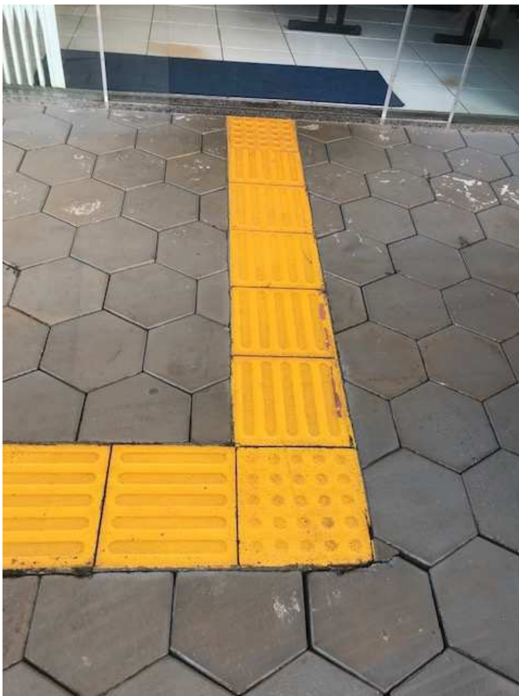
Piso podotátil com coloração inadequada e sem laje de concreto
