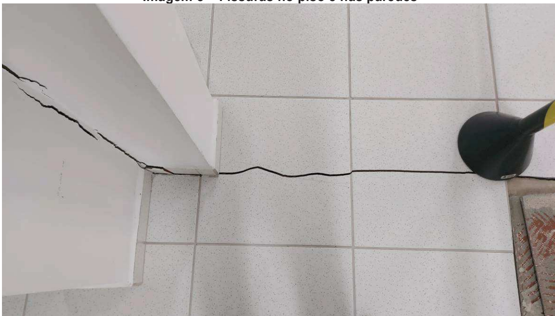
Imagem 6 – Fissuras no piso e nas paredes
