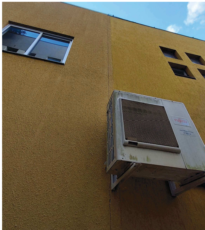
Imagem 3 – Fissura na parte externa do encontro de estruturas
