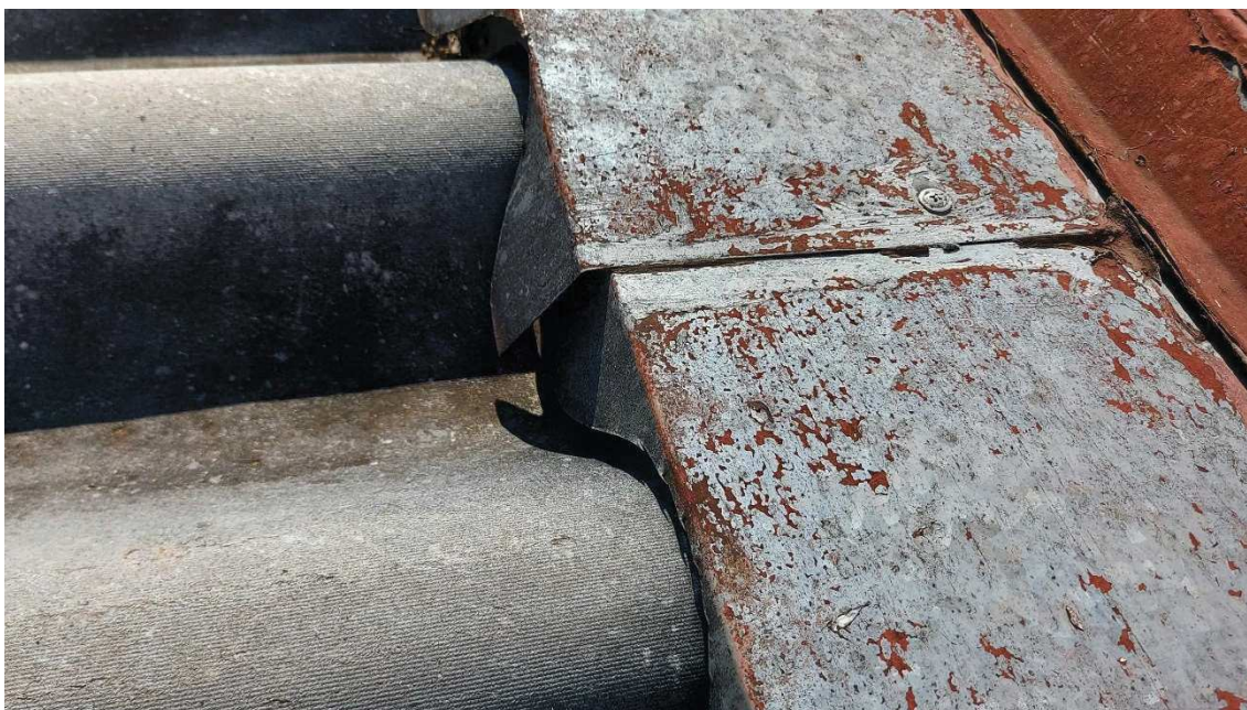
Imagem 8 – Falta de vedação na união entre elementos
