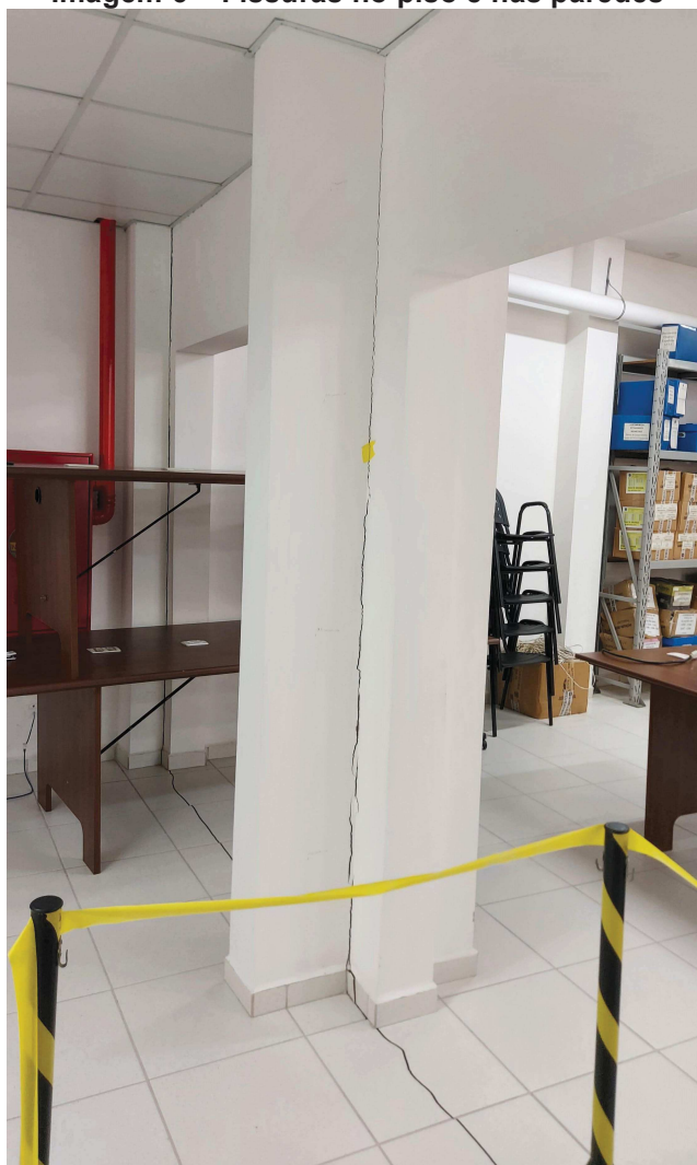
Imagem 6 – Fissuras no piso e nas paredes
