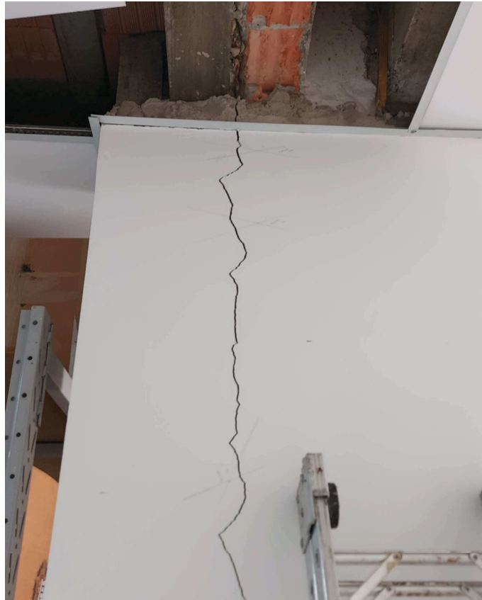
Imagem 2 – Rachadura no encontro de estruturas
