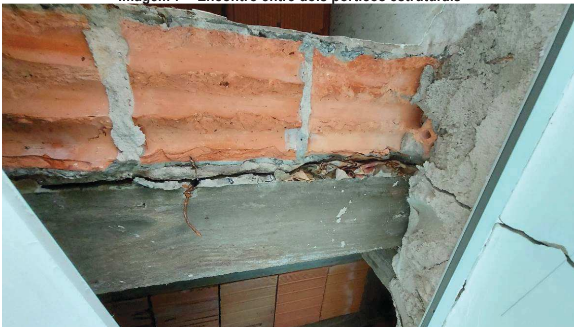
Imagem 8 – Fissura na parte externa
