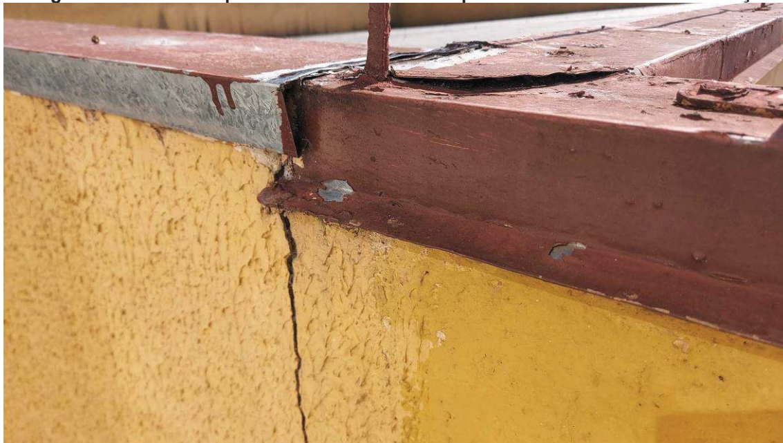
Imagem 9 – Fissura na parte externa e rufos de topo em mau estado de conservação
