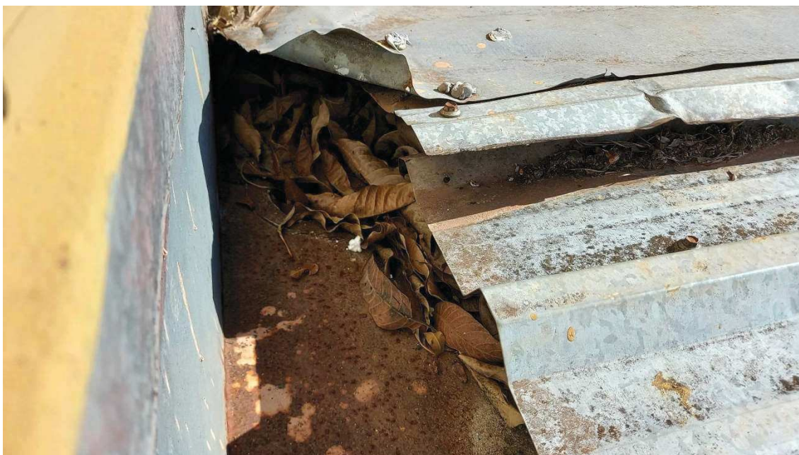
Imagem 10 – Calha com corrosão, suja e sem vedação na prumada
