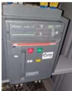
Figura 1 – Disjuntores ABB (Rede e Gerador)
