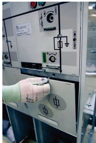
3. Desaparafuse o painel de fusíveis.
