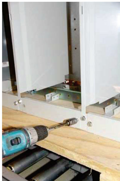
2. Remoção da seção frontal.
