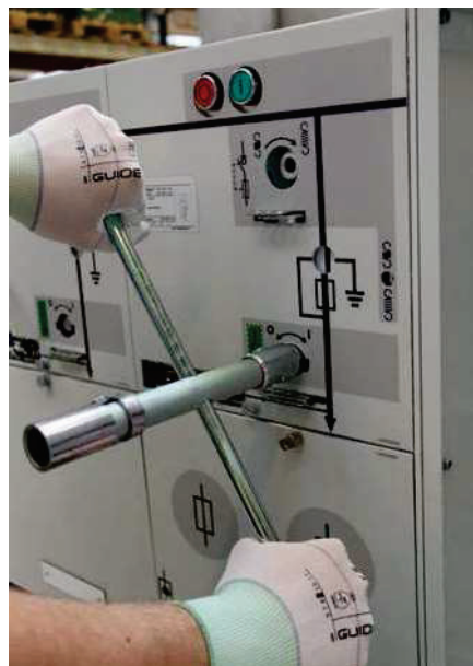
2. Feche o interruptor de aterramento girando a alavanca de operação no sentido horário.
