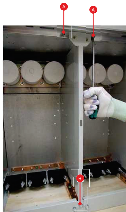
4. O painel central pode ser removido desaparafusando e .
