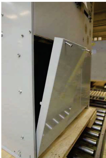
1. Desaperte os parafusos da tampa do cabo, puxe e levante a tampa.
