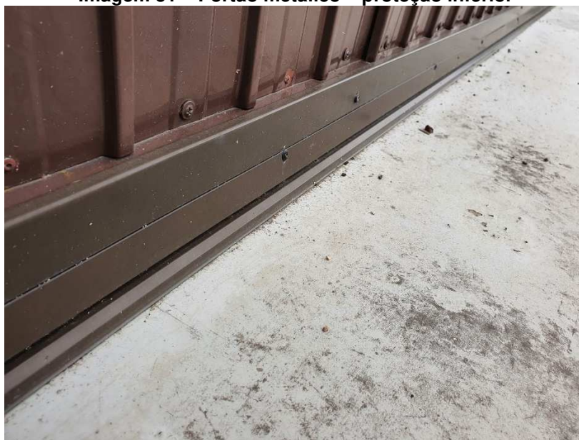
Imagem 31 – Portão metálico – proteção inferior
