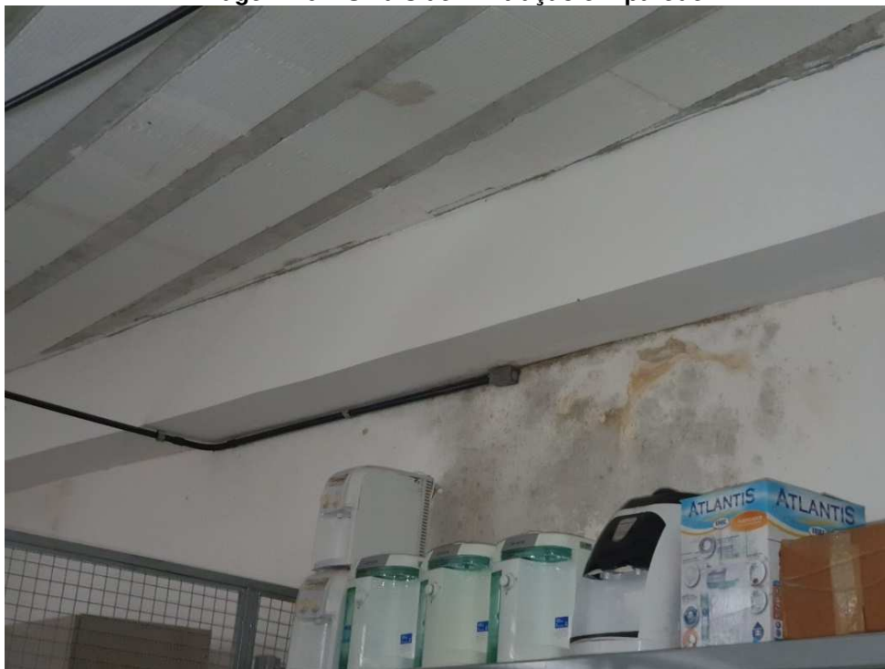
Imagem 26 – Sinais de infiltração em parede
