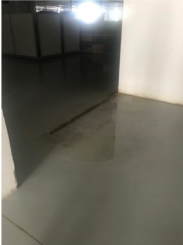
Imagem 11 – Água empoçada na área abaixo da junta de dilatação
