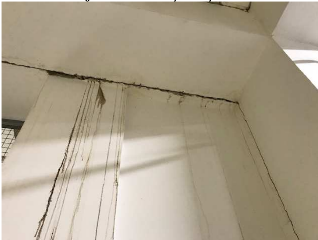
Imagem 9 - Junta de dilatação situação interna
