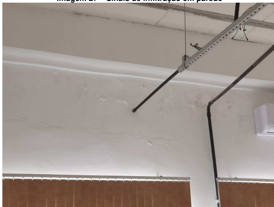
Imagem 27 – Sinais de infiltração em parede
