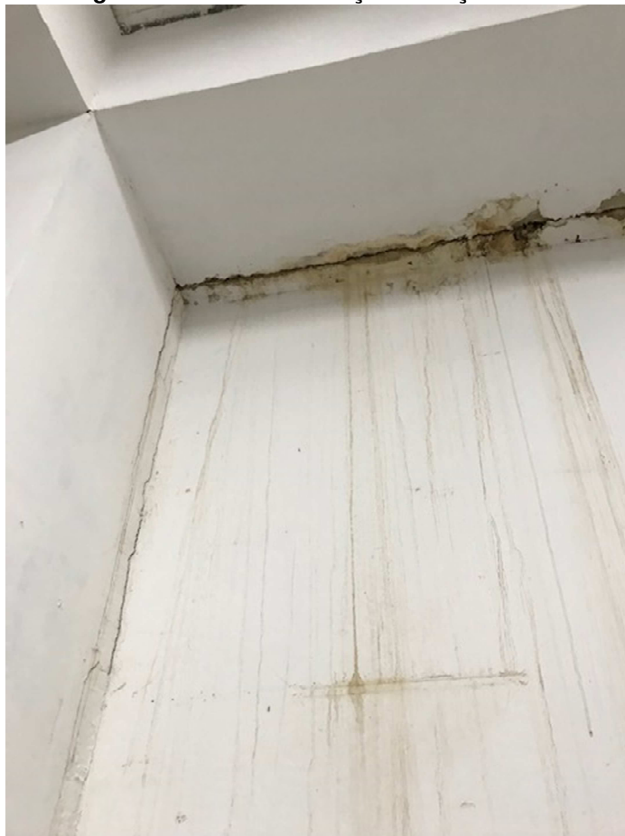
Imagem 8 - Junta de dilatação situação interna
