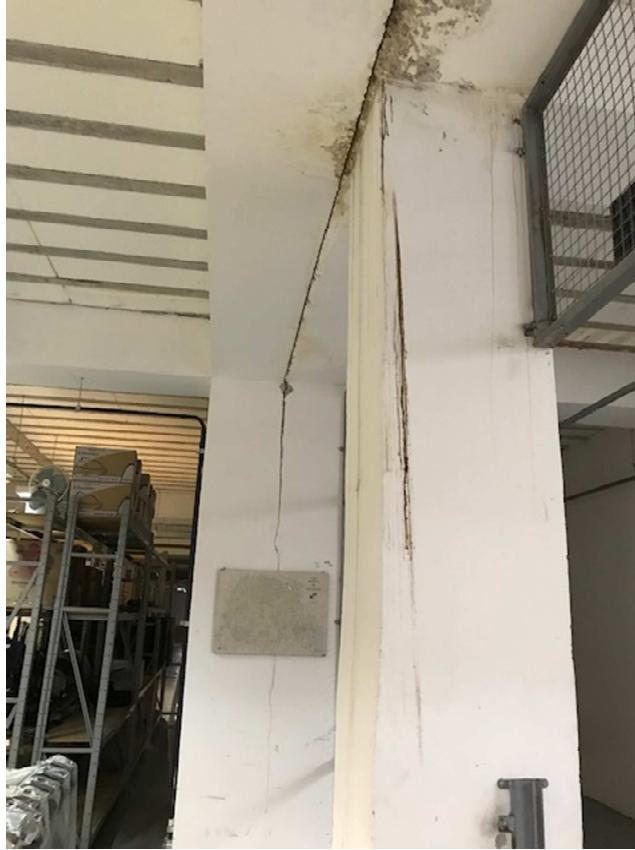
Imagem 10 - Junta de dilatação situação interna
