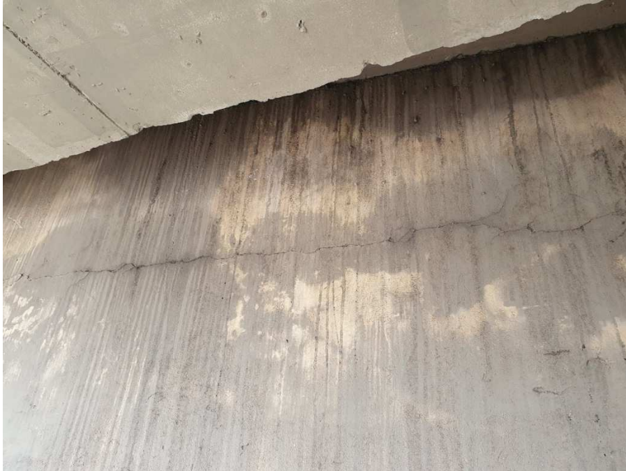
Imagem 28 – Junta de dilatação parede
