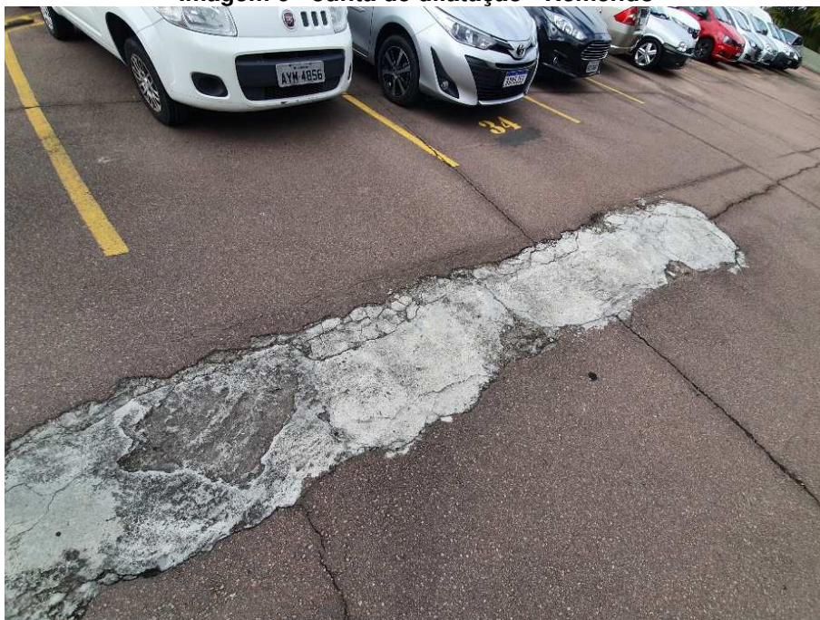
Imagem 6 - Junta de dilatação - Remendo
