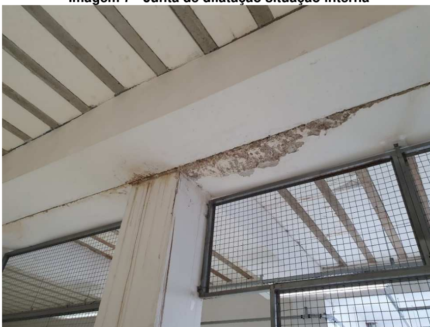
Imagem 7 - Junta de dilatação situação interna
