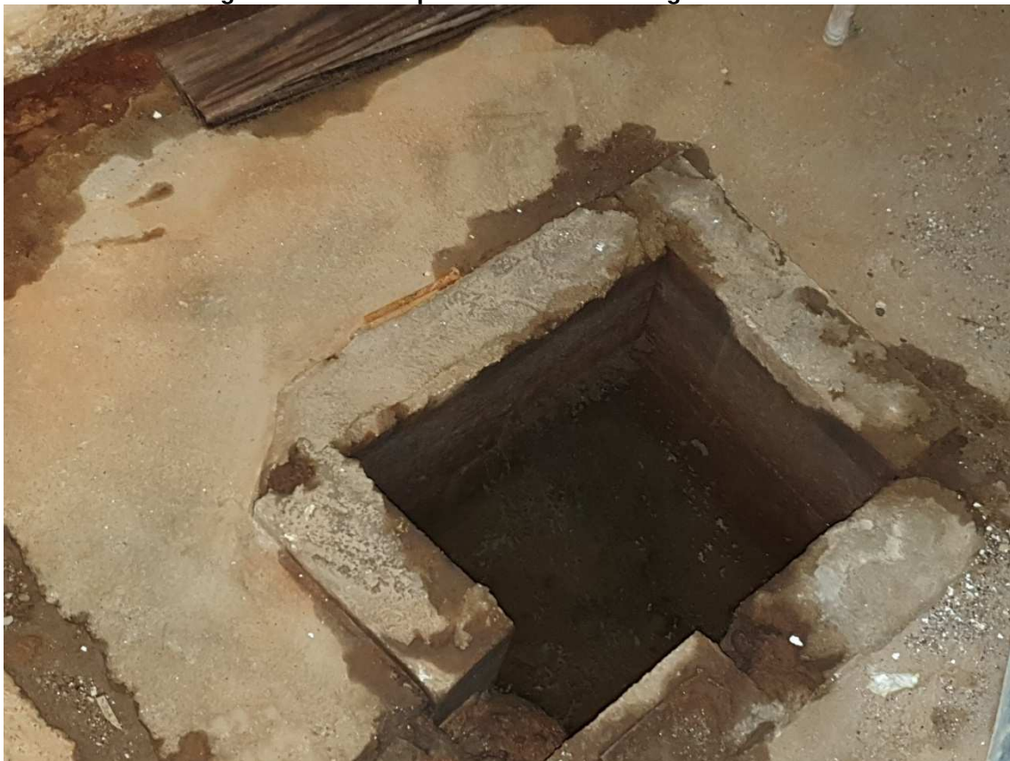
Imagem 25 – Buraco para escoamento da água acumulada
