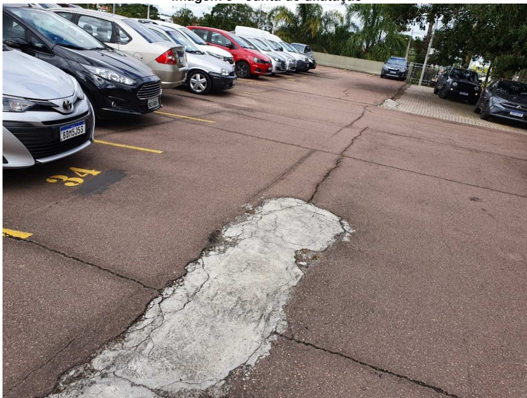
Imagem 5 - Junta de dilatação
