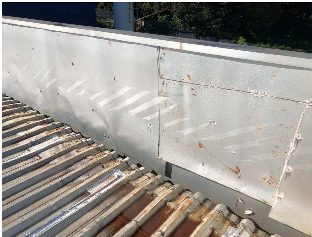
Correções de infiltrações provocadas pela platibanda
