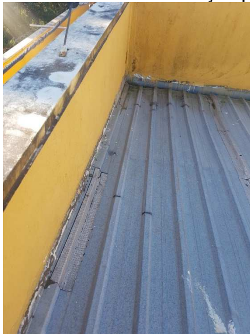
Imagem 26 – Cobertura – Rufo mal instalado e soluções paliativas com manta
