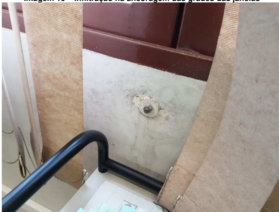
Imagem 19 – Infiltração na ancoragem das grades das janelas
