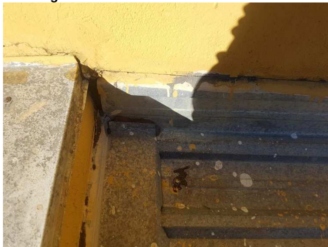
Imagem 25 – Cobertura – Rufo mal instalado
