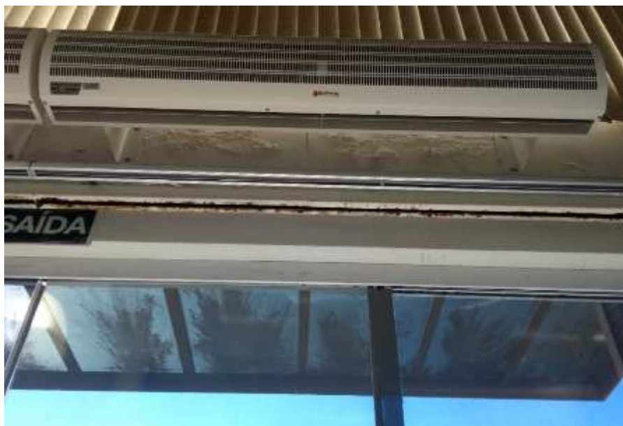
Imagem 18 – Infiltração interna causada pela falta de vedação
