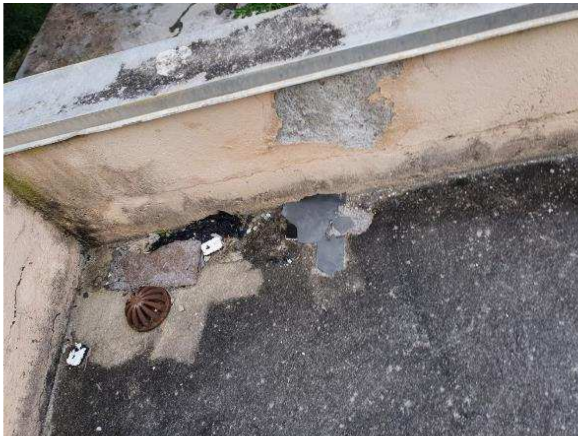
Imagem 28 – Platibandas com emboço se deteriorando
