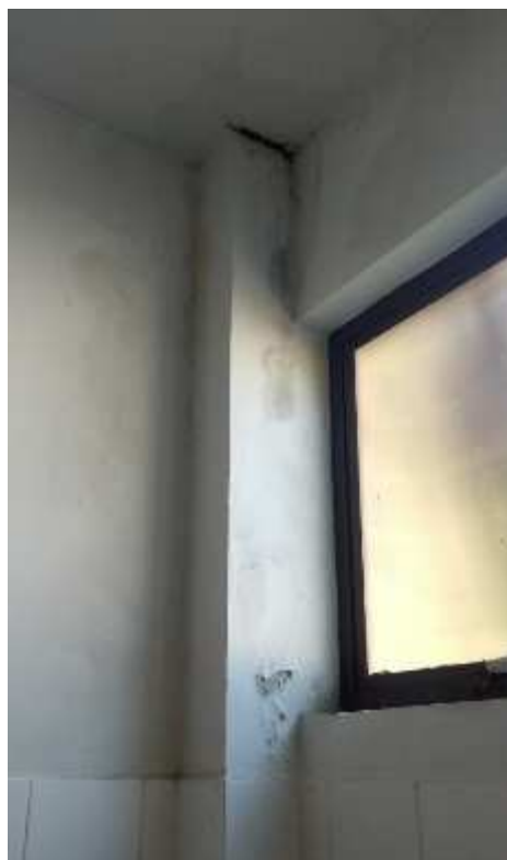
Imagem 23 – Infiltração no banheiro feminino
