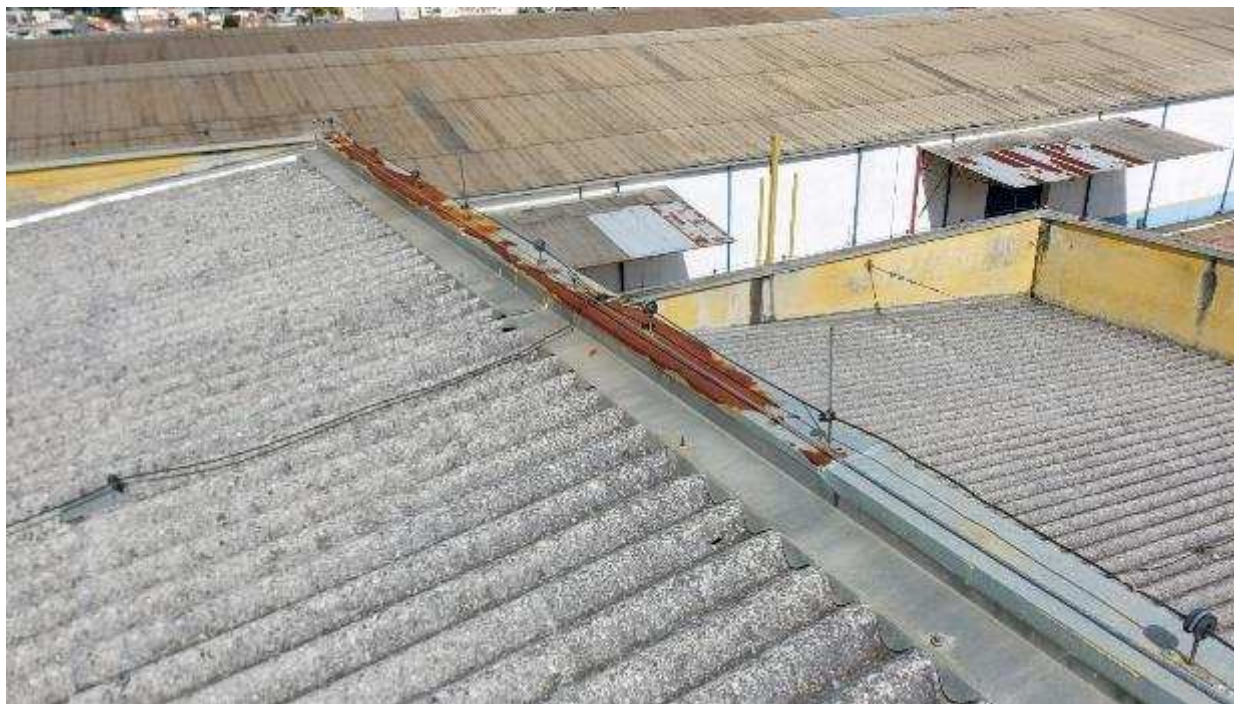
Imagem 29 – Rufos em processo de corrosão
