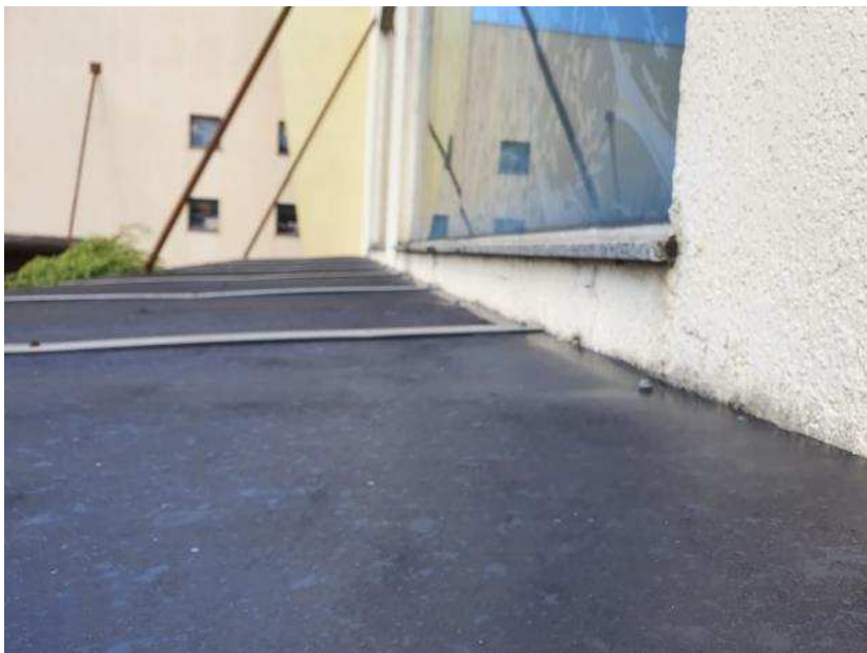
Imagem 17 – Falta de vedação entre toldo e parede
