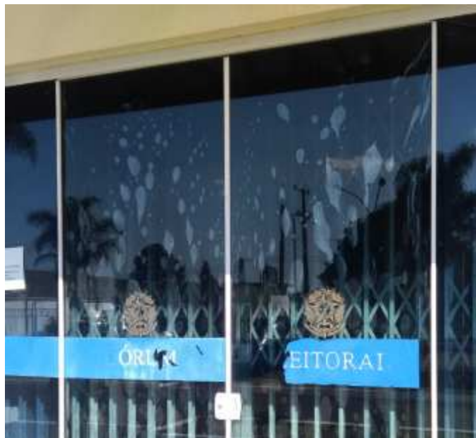
Imagem 15 – Bolhas nas películas da porta de entrada
