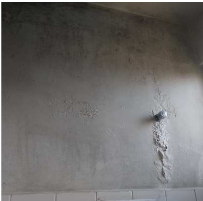
Imagem 21 – Infiltração no banheiro masculino
