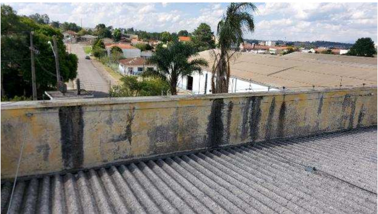
Imagem 27 – Platibandas se deteriorando
