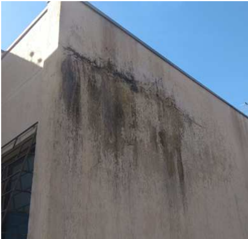
Imagem 22 – Trinca externa
