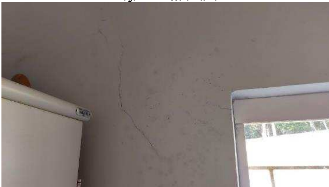
Imagem 24 – Fissura interna
