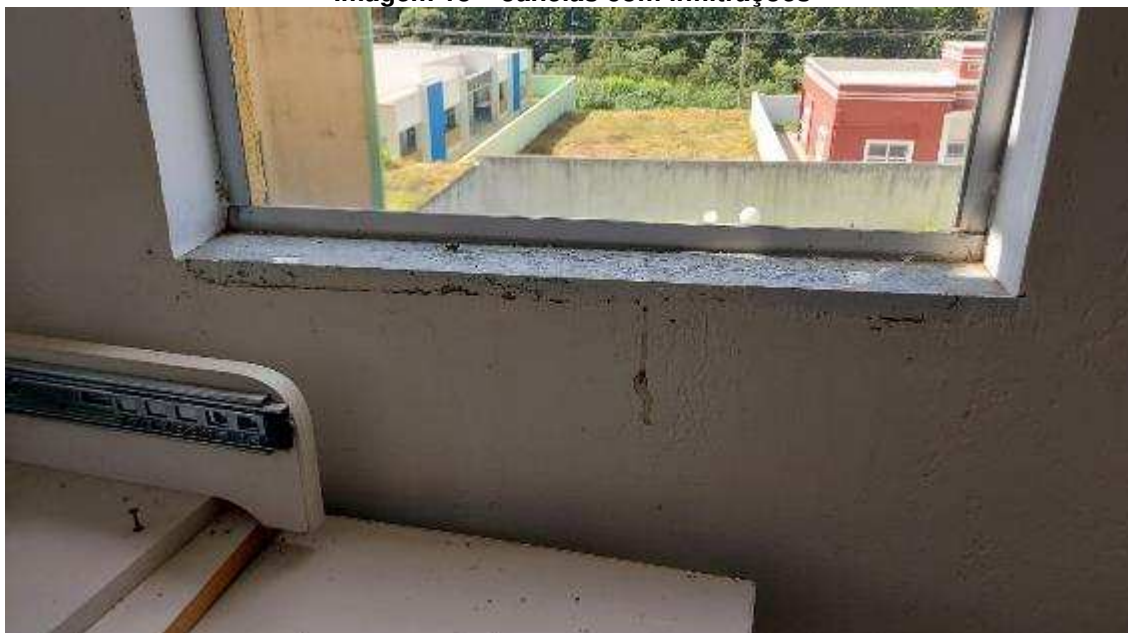
Imagem 18 – Janelas com infiltrações
