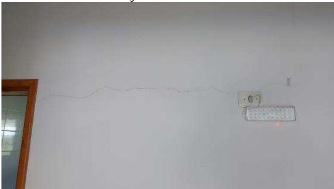
Imagem 22 – Fissura interna
