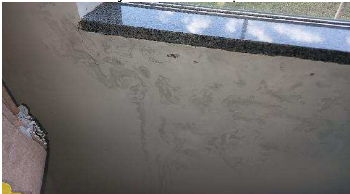
Imagem 16 – Janelas com infiltrações
