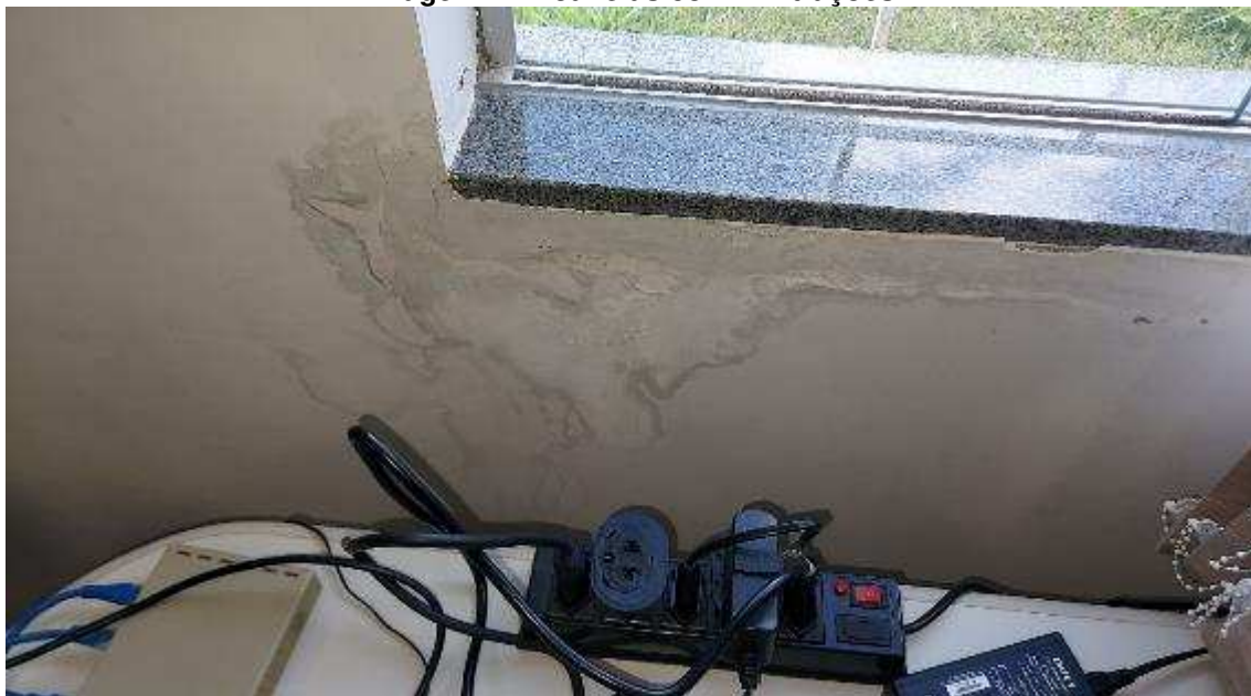
Imagem 17 – Janelas com infiltrações
