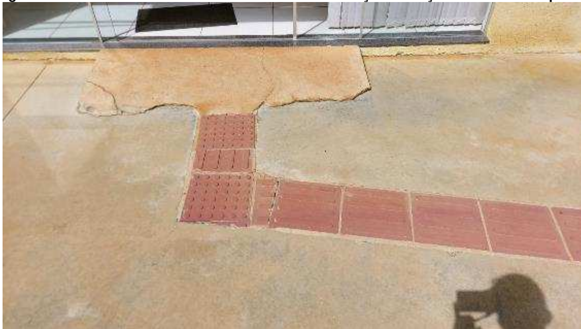
Imagem 5 – Piso tátil em desacordo com a NBR na mudança de direção e acabamento precário
