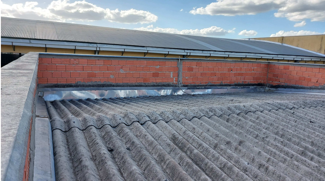
Imagem 9 – Ausência de emboço na platibanda
