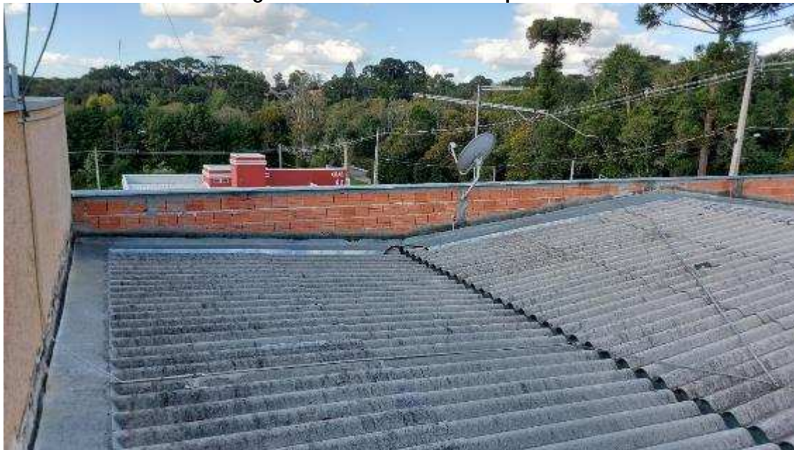
Imagem 11 – Telhas com falhas pontuais
