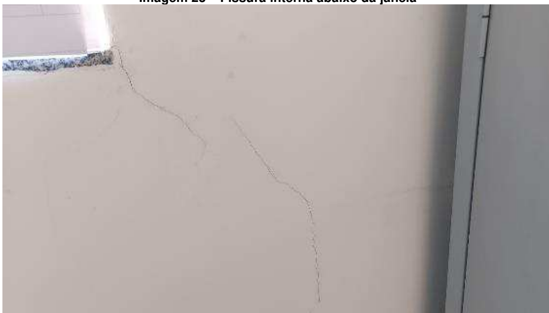
Imagem 23 – Fissura interna abaixo da janela
