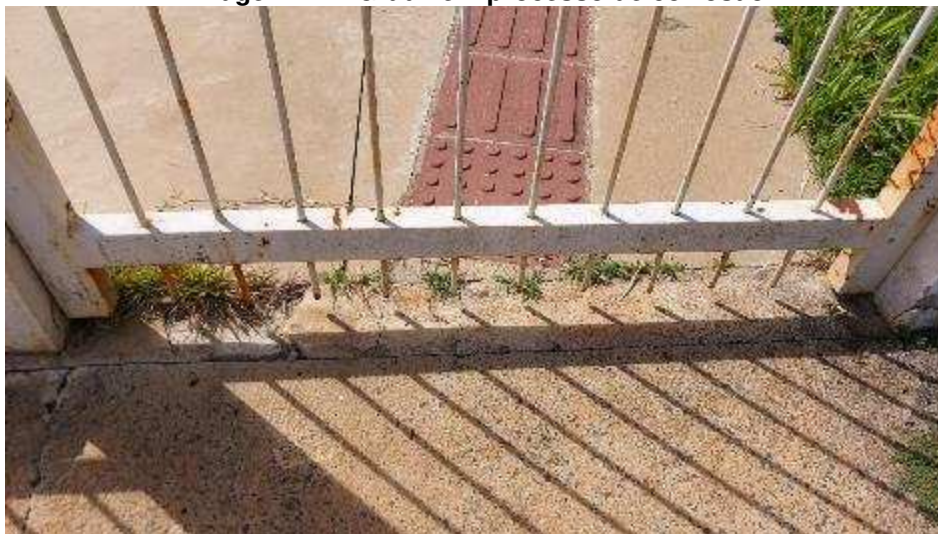
Imagem 27 – Gradil em processo de corrosão
