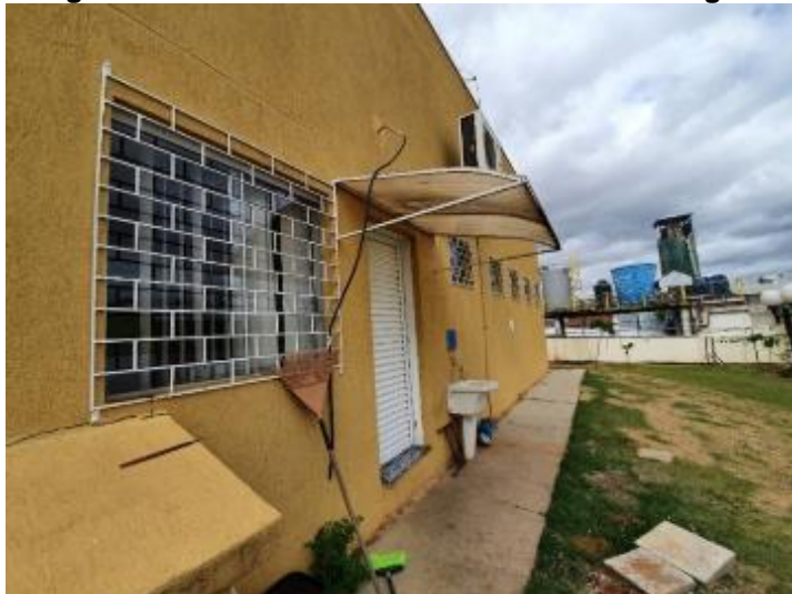
Imagem 53 – Dreno de ar condicionado com mangueira
