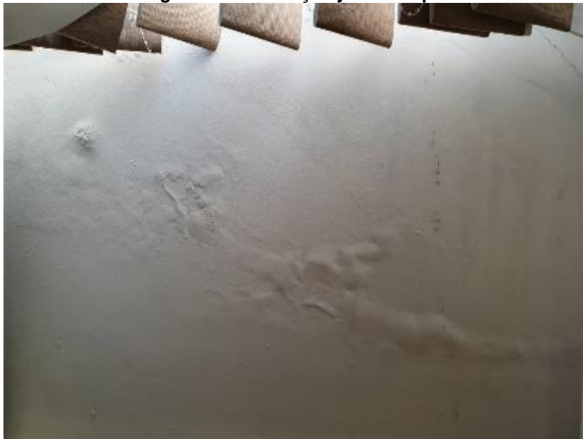
Imagem 34 – Infiltração janela Arquivo
