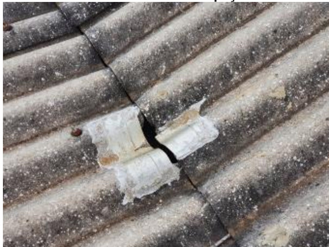
Imagem 60 – Cobertura – Telhas sem espaçamento sobre a calha
