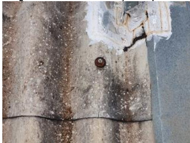
Imagem 62 – Cobertura – Oxidação dos parafusos
