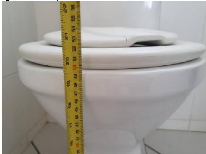
Imagem 14 – Tampa danificada Sanitário Masculino da C.A.E.
