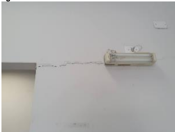
Imagem 42 – Trinca vão hall dos sanitários da C.A.E.
