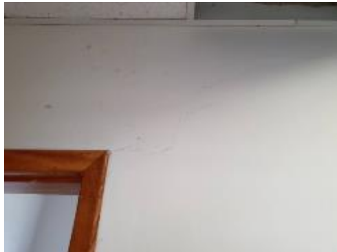
Imagem 43 – Trinca Sanitário Masculino da C.A.E.
