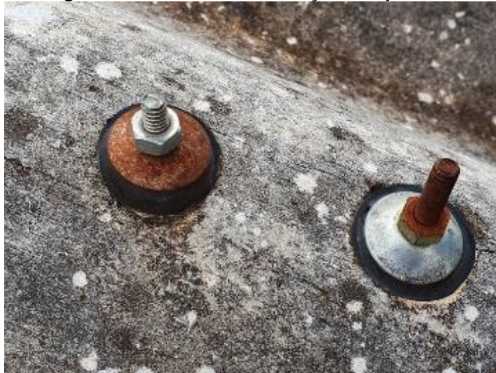
Imagem 63 – Cobertura – Oxidação dos parafusos
