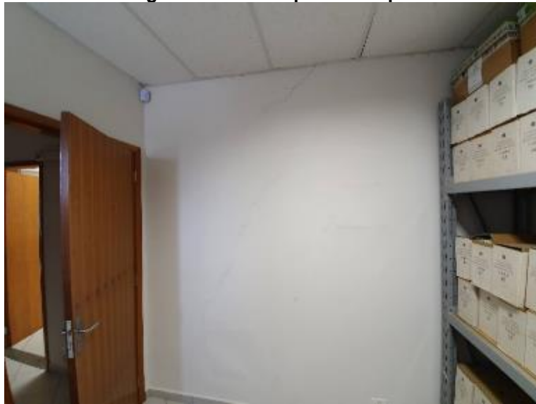
Imagem 45 – Trinca parede Arquivo
