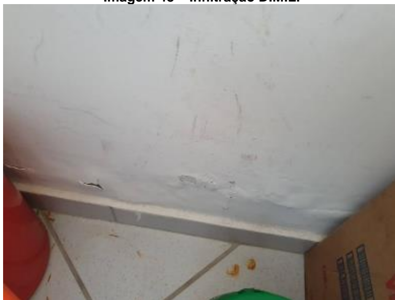
Imagem 48 – Infiltração D.M.L.
