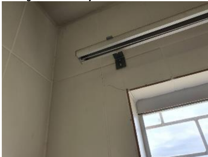
Imagem 38 – Trinca janela sanitário dos cartórios
