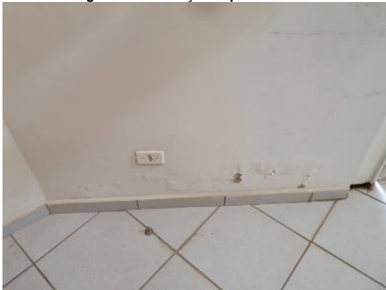
Imagem 47 – Infiltração Depósito de Urnas
