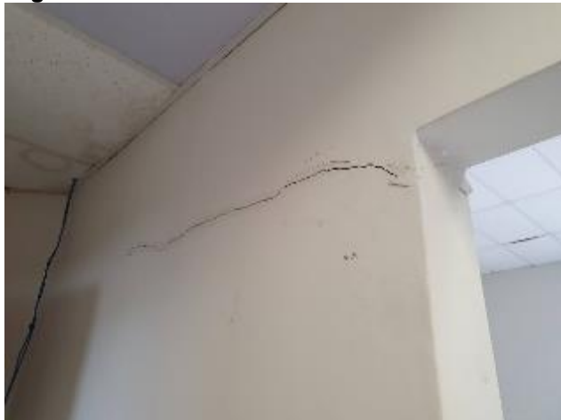
Imagem 41 – Trinca vão hall dos sanitários da C.A.E.
