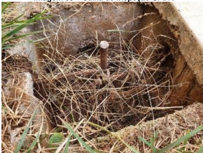
Imagem 69 – Caixa de inspeção SPDA
