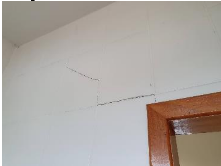
Imagem 44 – Trinca Sanitário Masculino da C.A.E.
