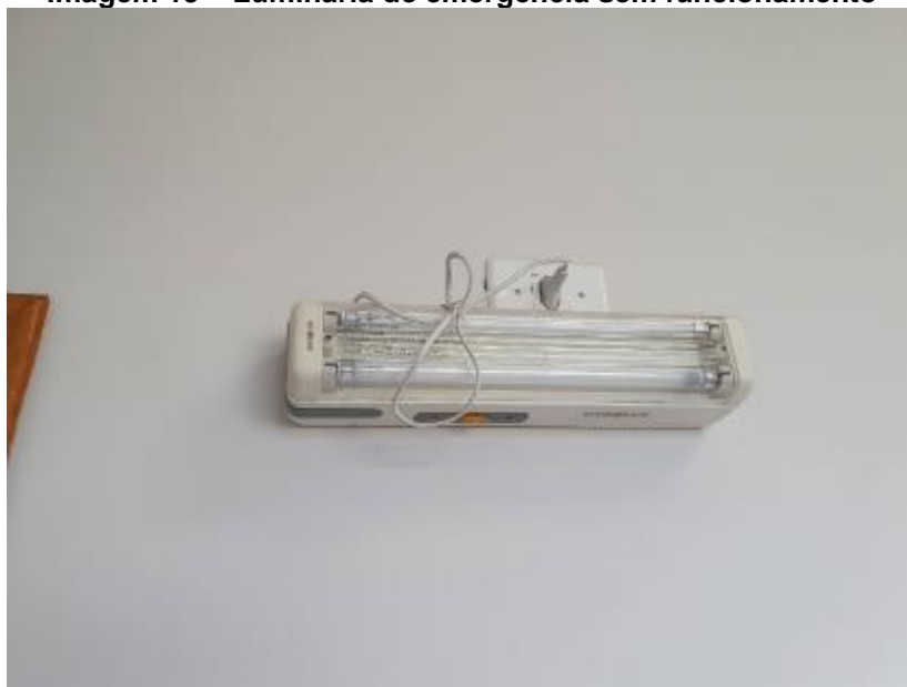
Imagem 19 – Luminária de emergência sem funcionamento
