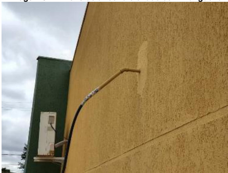
Imagem 54 – Dreno de ar condicionado com mangueira
