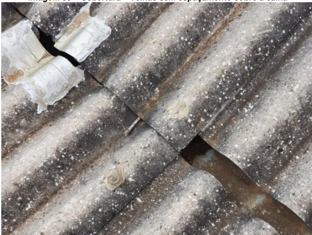
Imagem 59 – Cobertura – Telhas sem espaçamento sobre a calha
