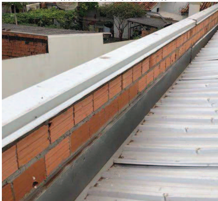
Platibanda sem revestimento
