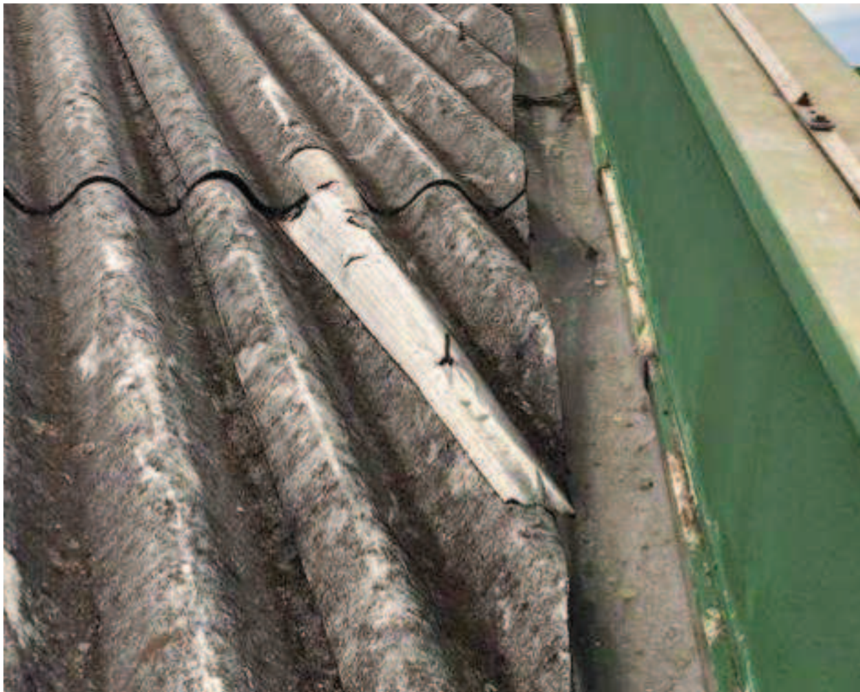
Manta asfáltica sobre a telha
