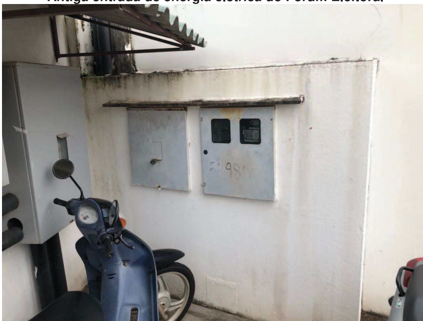
Antiga entrada de energia elétrica do Fórum Eleitoral
