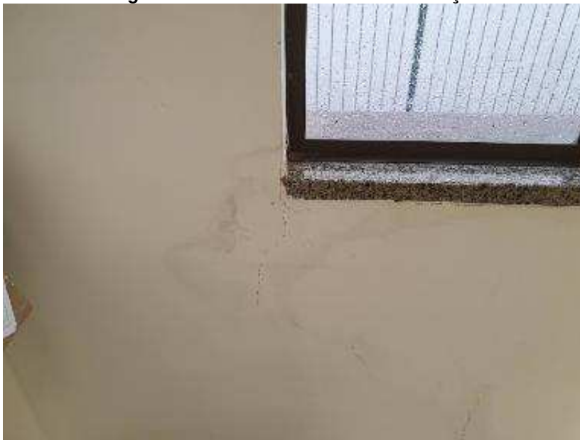
Imagem 78 – Janelas – Sinais de infiltrações
