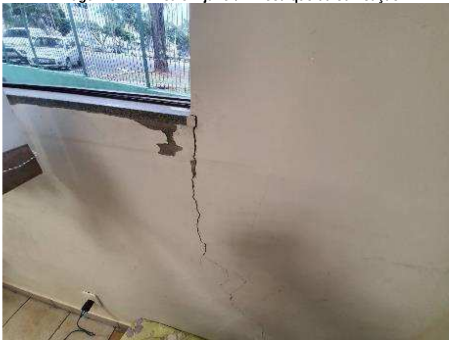
Imagem 87 – Trinca em janela – Recalque da edificação
