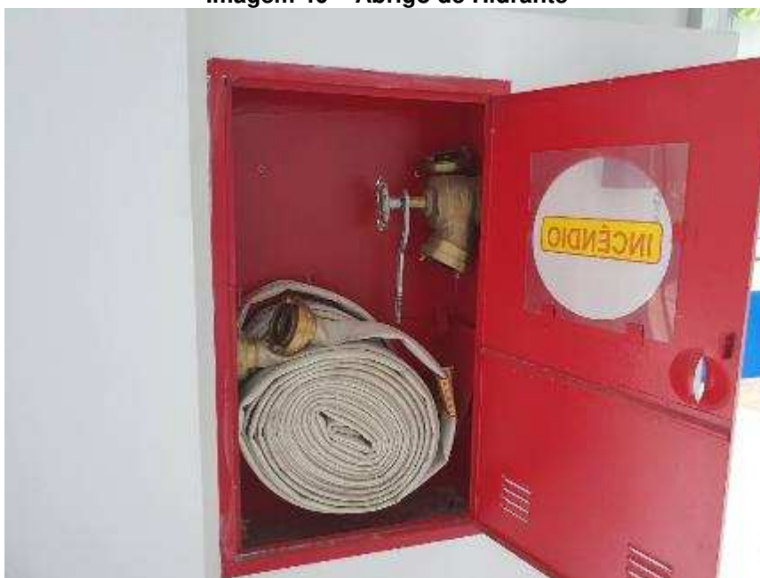
Imagem 40 – Abrigo de Hidrante
