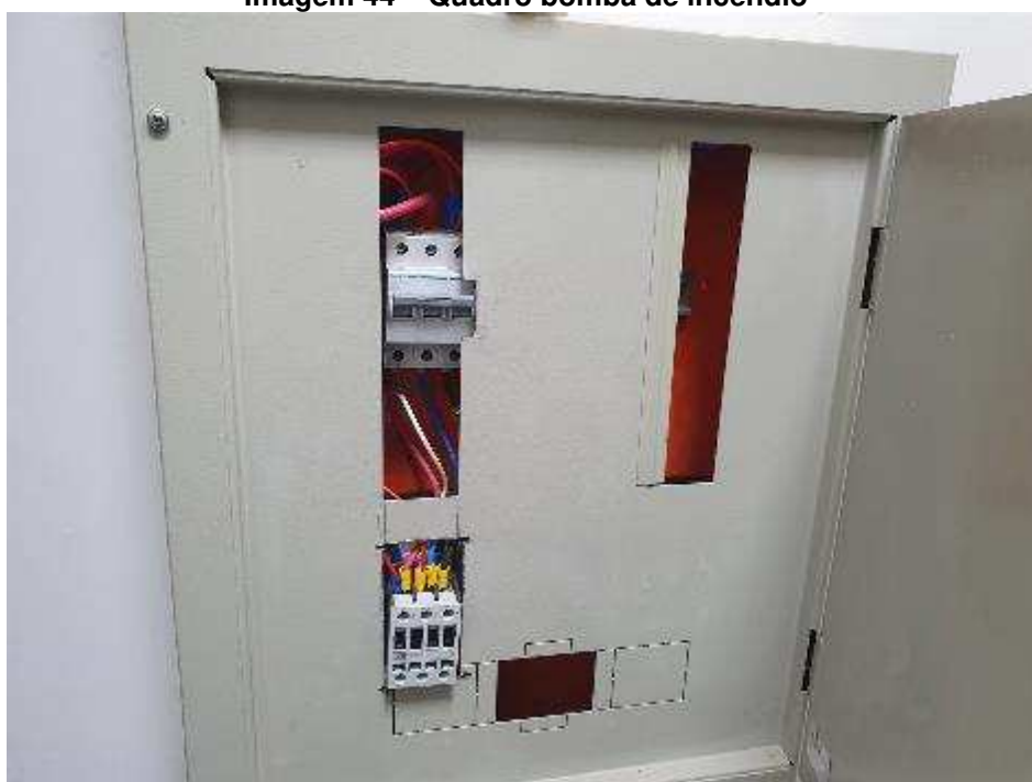
Imagem 44 – Quadro bomba de incêndio
