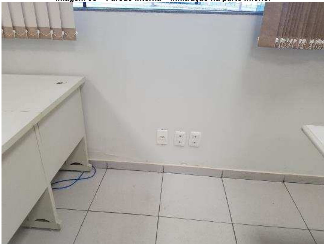
Imagem 98 – Parede interna – infiltração na parte inferior
