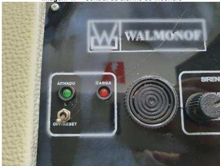
Imagem 47 – Central de alarme de incêndio
