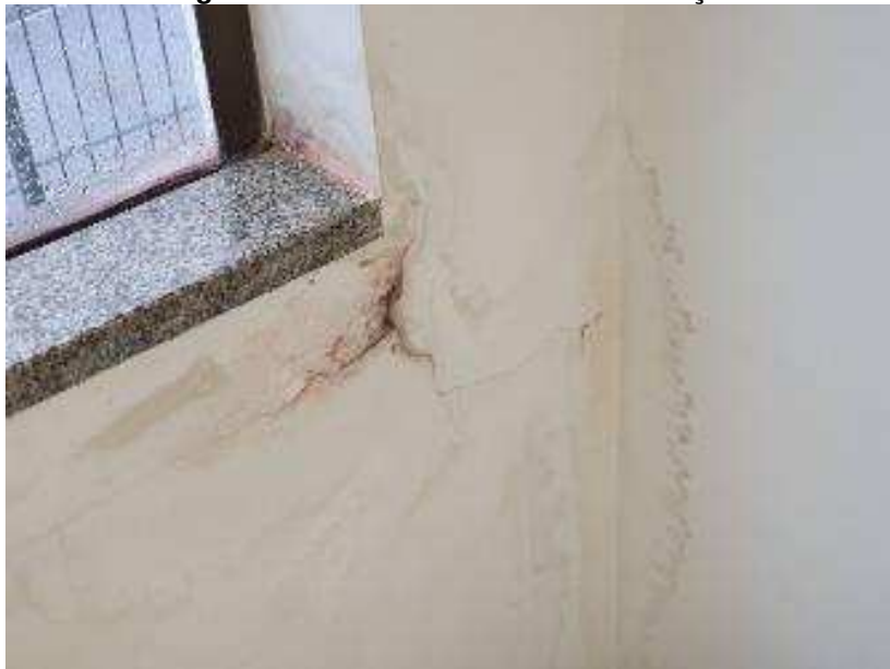
Imagem 77 – Janelas – Sinais de infiltrações
