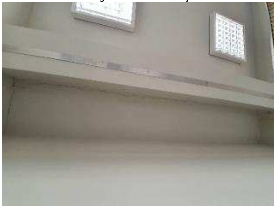
Imagem 80 – Trinca em laje
