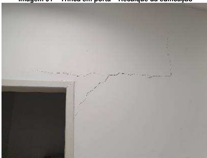
Imagem 91 – Trinca em porta – Recalque da edificação
