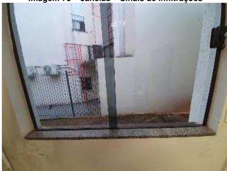
Imagem 73 – Janelas – Sinais de infiltrações
