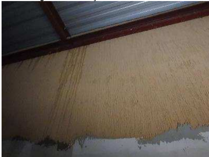
Imagem 85 – Infiltração cobertura sala multiuso
