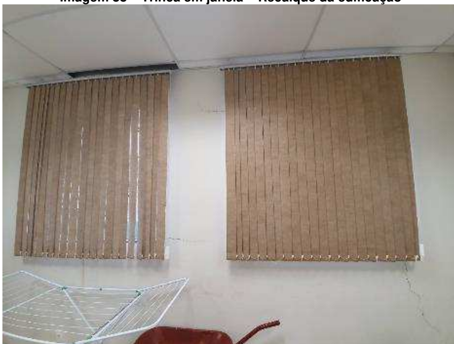
Imagem 88 – Trinca em janela – Recalque da edificação
