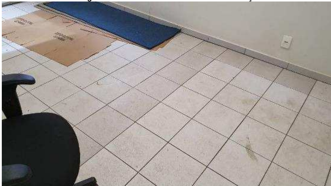
Imagem 92 – Piso cerâmico – Sinais de infiltração
