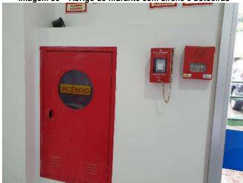
Imagem 50 – Abrigo de hidrante com sirene e botoeiras
