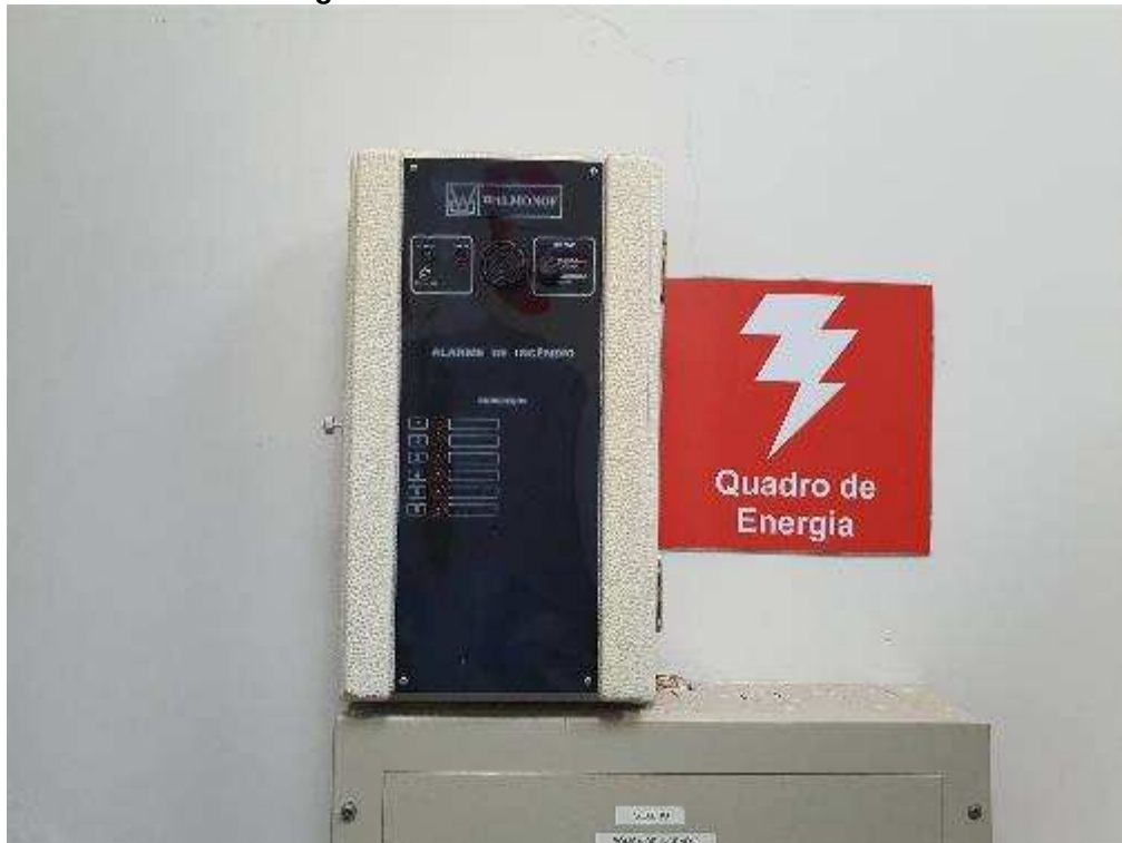
Imagem 46 – Central de alarme de incêndio
