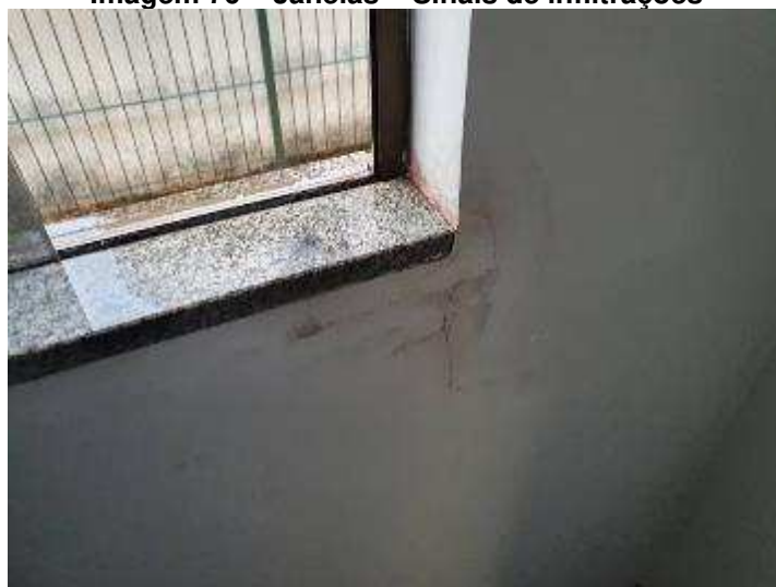
Imagem 76 – Janelas – Sinais de infiltrações
