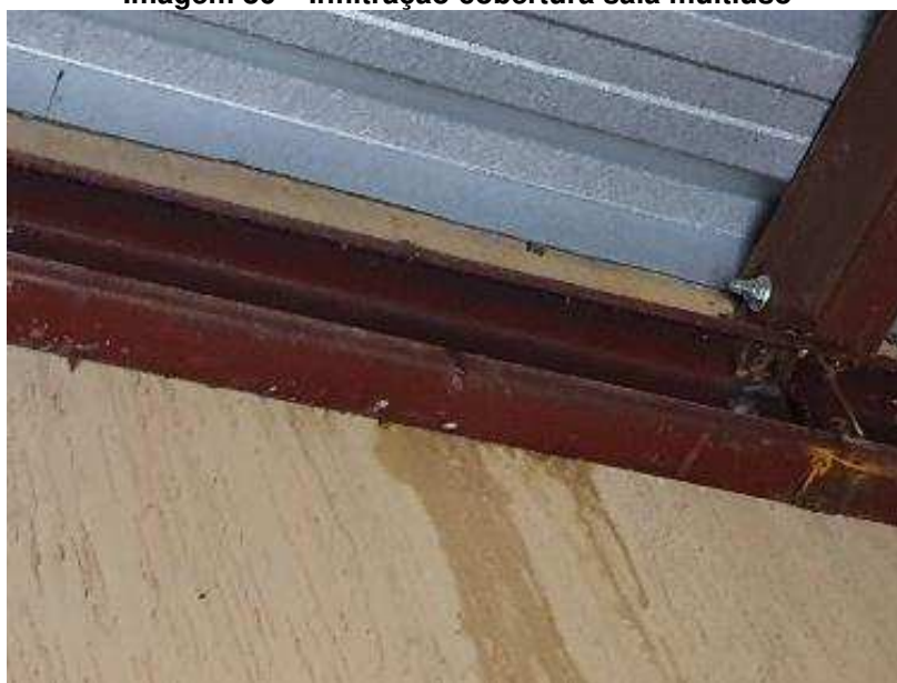
Imagem 86 – Infiltração cobertura sala multiuso
