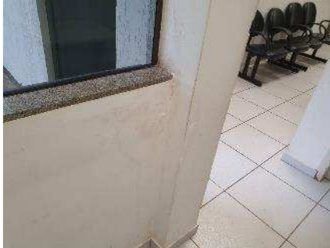
Imagem 74 – Janelas – Sinais de infiltrações
