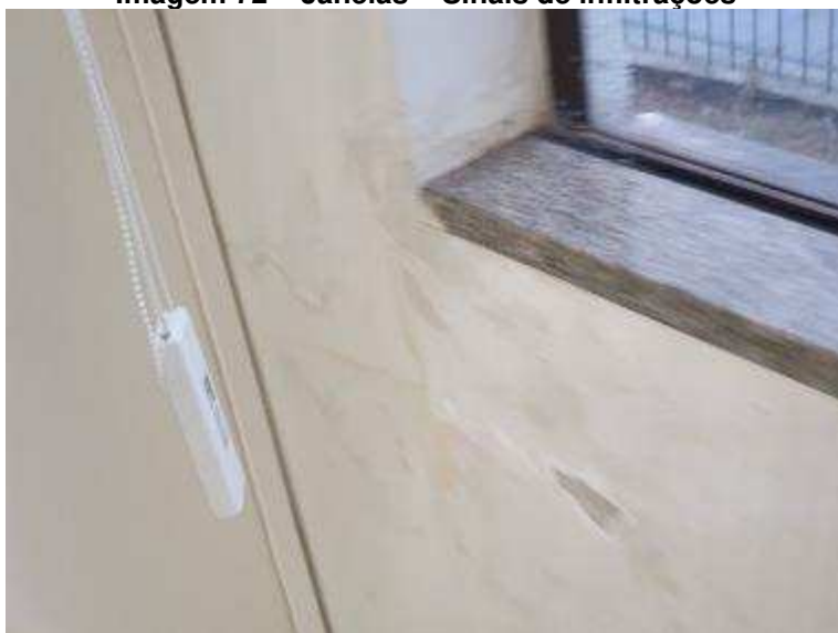
Imagem 72 – Janelas – Sinais de infiltrações
