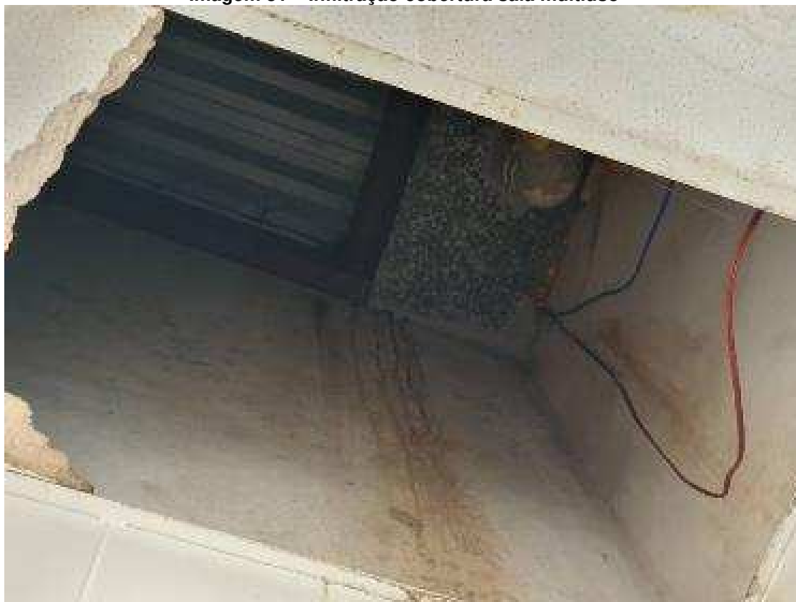
Imagem 81 – Infiltração cobertura sala multiuso
