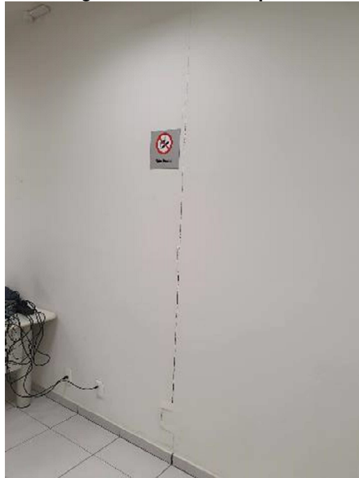
Imagem 79 – Trinca em parede
