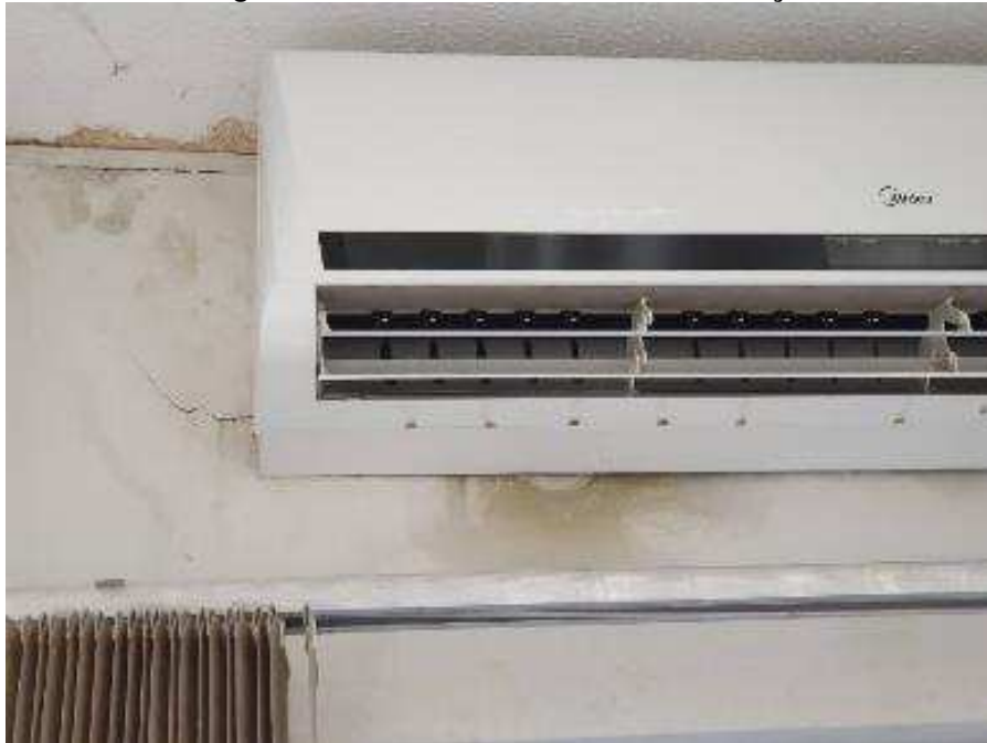
Imagem 61 – Ar Condicionado com infiltração
