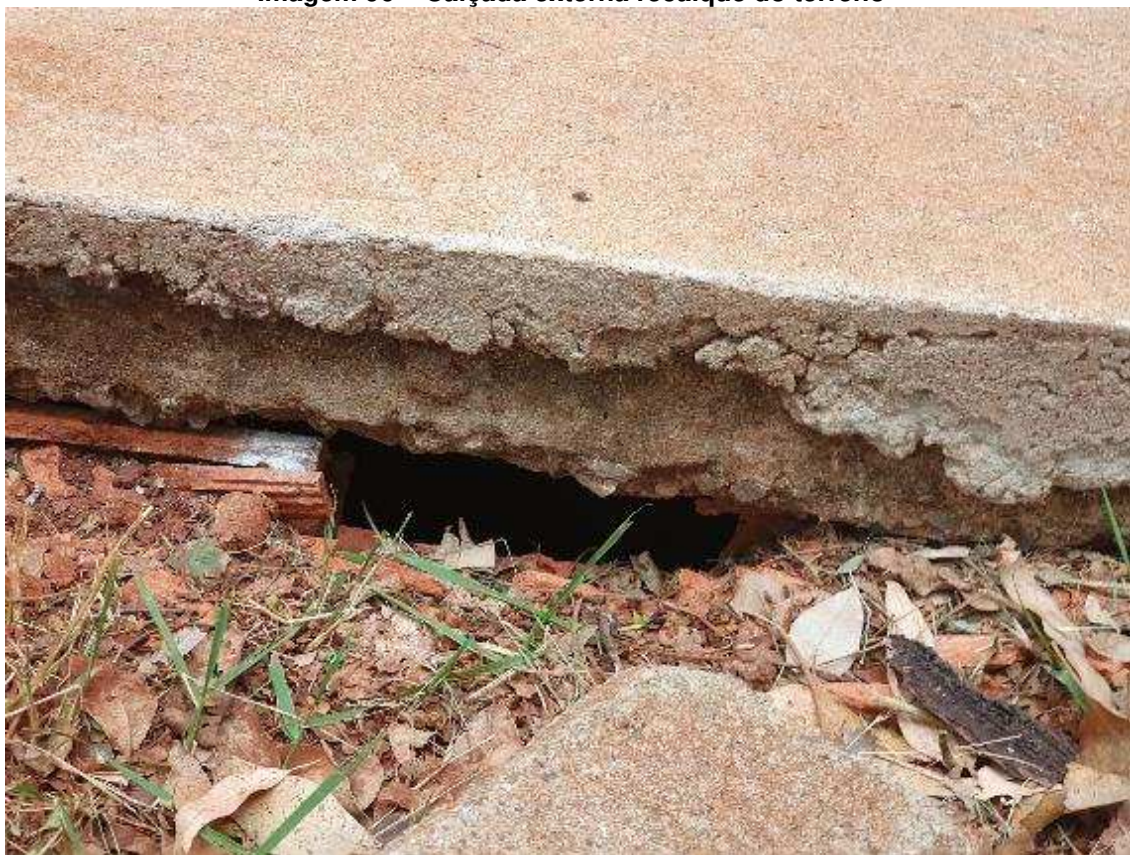
Imagem 96 – Calçada externa recalque do terreno
