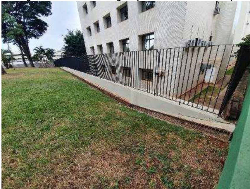
Imagem 103 – Canaleta de águas pluviais – Câmara Municipal
