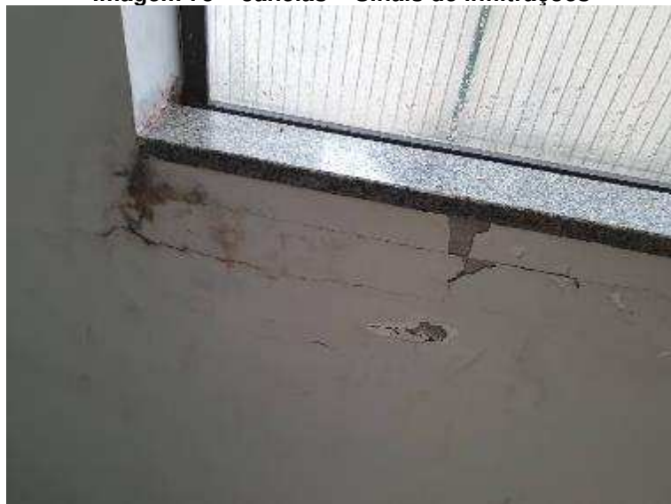
Imagem 75 – Janelas – Sinais de infiltrações
