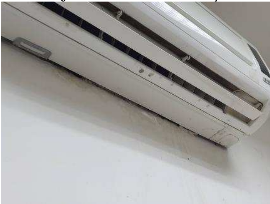
Imagem 62 – Ar Condicionado com infiltração
