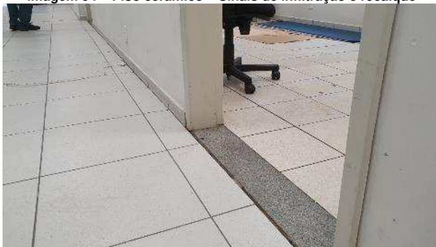
Imagem 94 – Piso cerâmico – Sinais de infiltração e recalque
