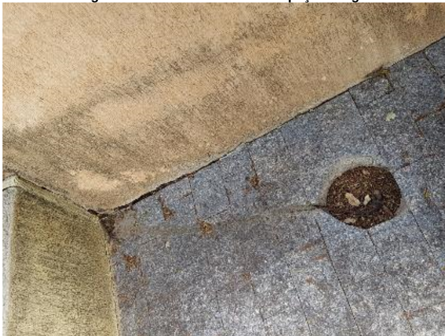
Imagem 104 – SPDA – Caixa de inspeção irregular
