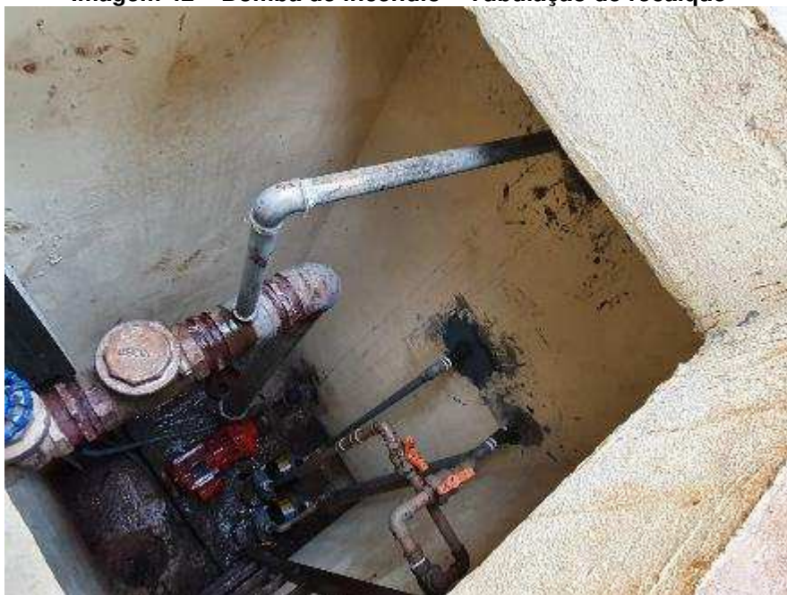
Imagem 42 – Bomba de incêndio – Tubulação de recalque
