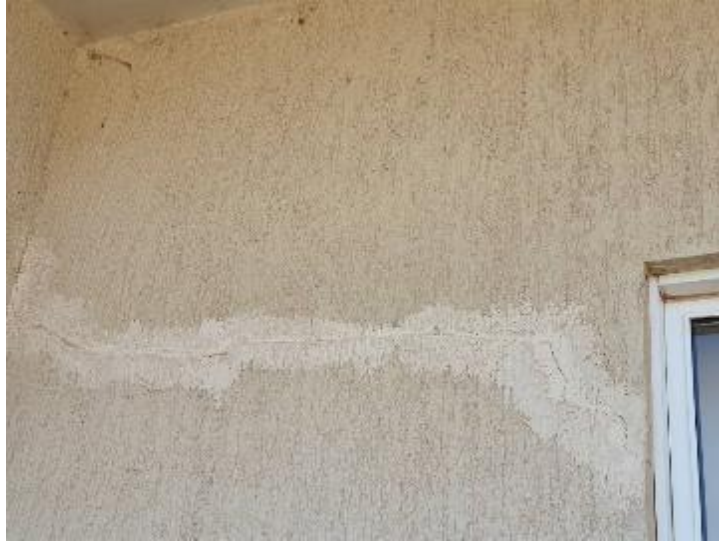
Imagem 51 – Trinca externa com correção
