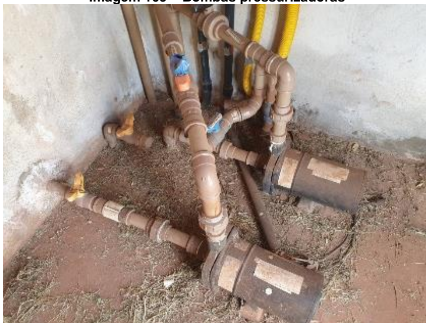
Imagem 109 – Bombas pressurizadoras
