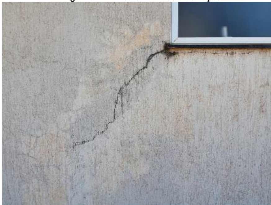
Imagem 57 – Trinca externa sem correção
