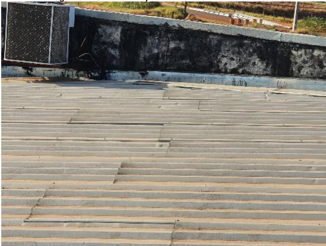
Imagem 62 – Cobertura Depósito de Urnas – Telhas amassadas
