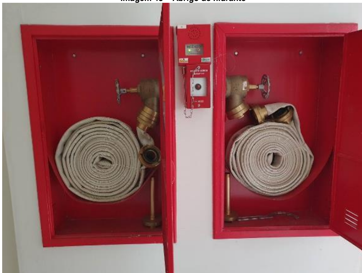
Imagem 43 – Abrigo de hidrante
