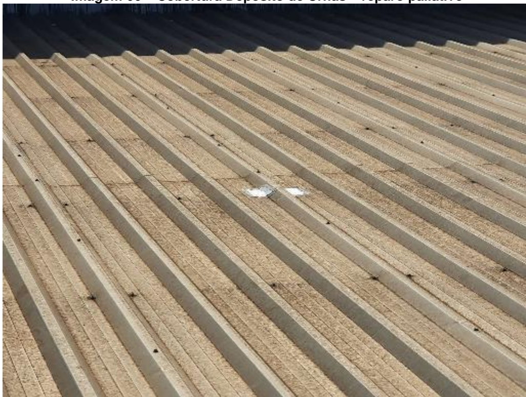
Imagem 66 – Cobertura Depósito de Urnas – reparo paliativo
