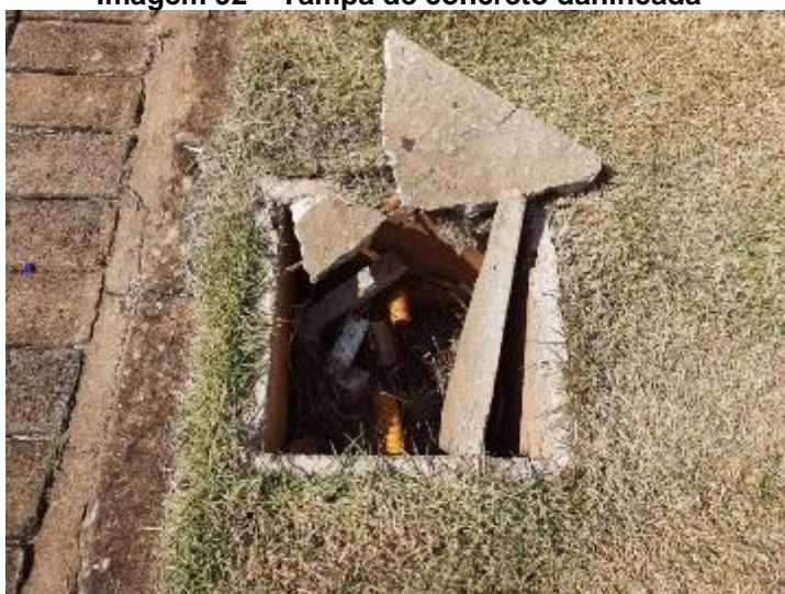
Imagem 92 – Tampa de concreto danificada
