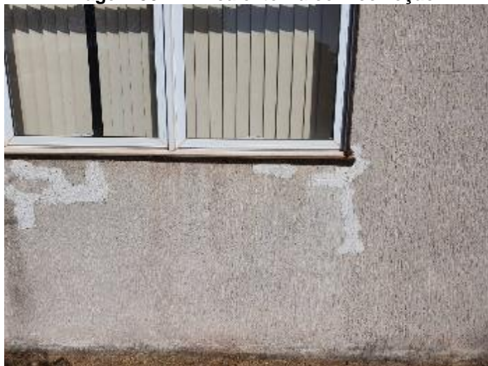
Imagem 53 – Trinca externa com correção
