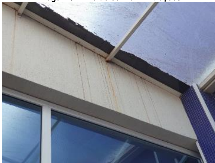
Imagem 87 – Toldo central infiltrações
