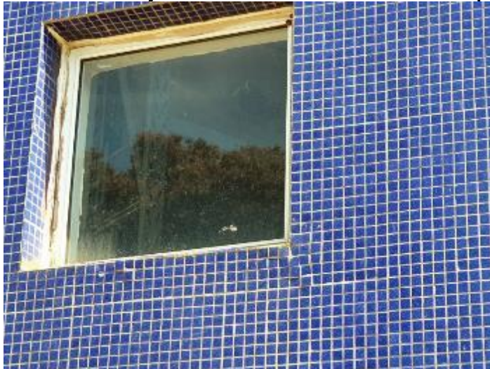
Imagem 55 – Trinca de janelas externas no revestimento de pastilhas
