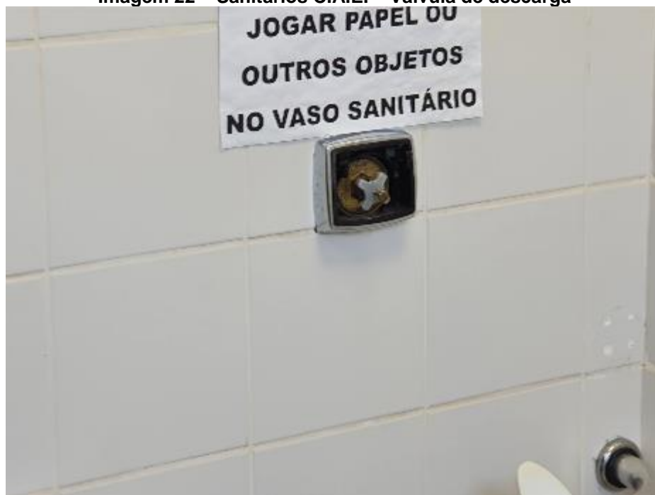
Imagem 22 – Sanitários C.A.E. – Válvula de descarga
