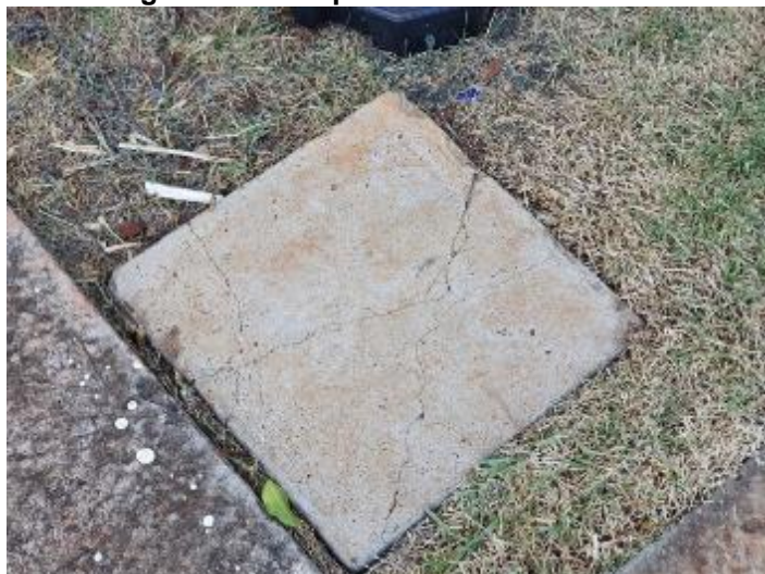
Imagem 91 – Tampa de concreto danificada
