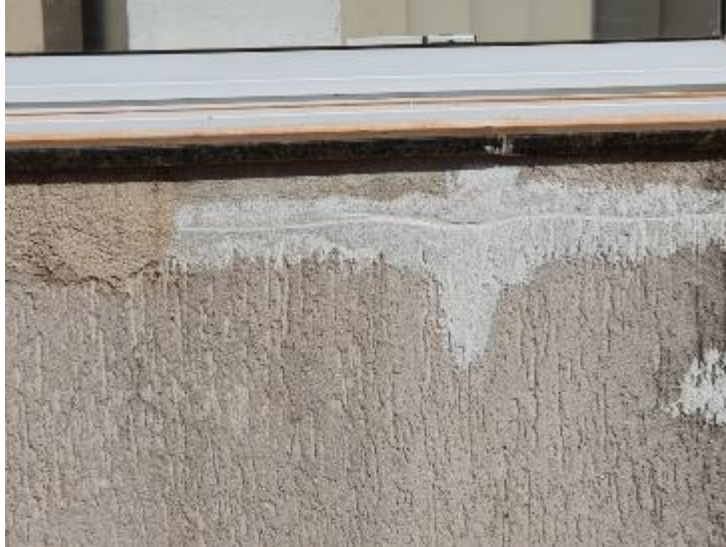
Imagem 54 – Trinca externa com correção
