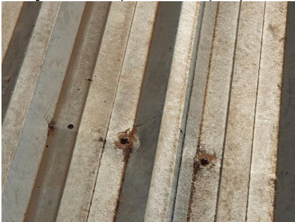
Imagem 65 – Cobertura Depósito de Urnas – Vedação dos parafusos
