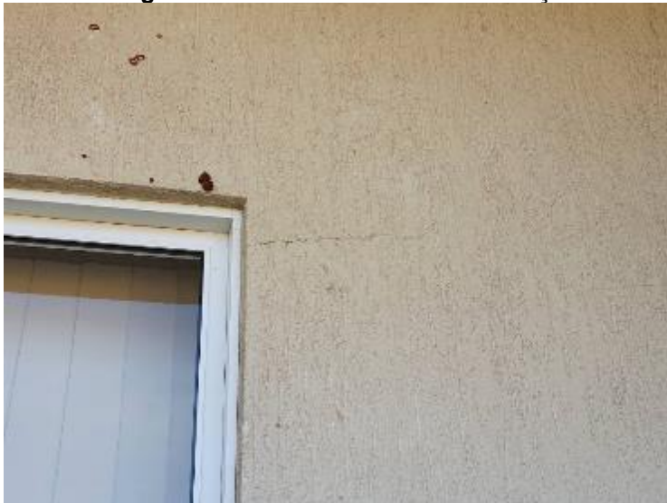
Imagem 52 – Trinca externa sem correção
