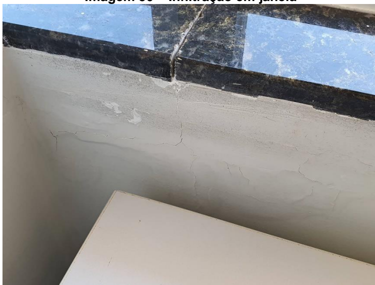
Imagem 50 – Infiltração em janela
