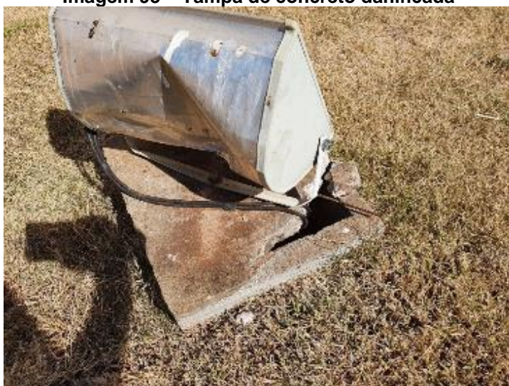
Imagem 93 – Tampa de concreto danificada
