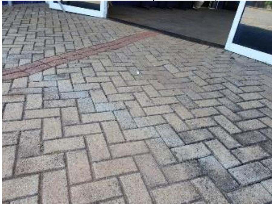
Imagem 5 – Porta da edificação – Falhas no piso
