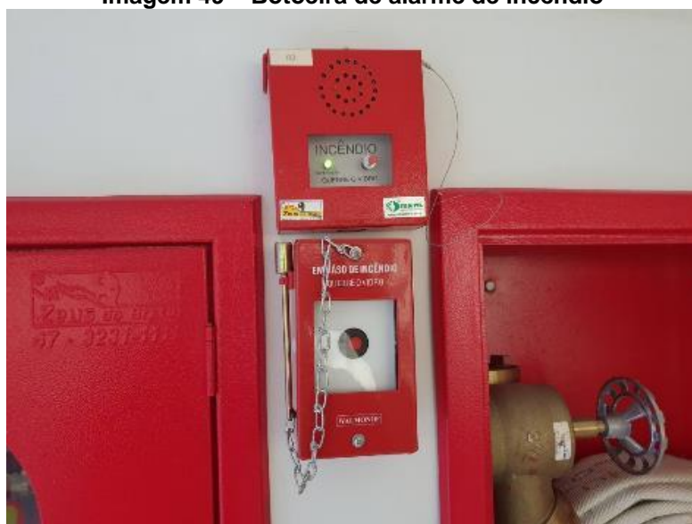
Imagem 49 – Botoeira de alarme de incêndio
