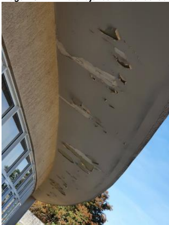
Imagem 94 – Pintura laje técnica da fachada
