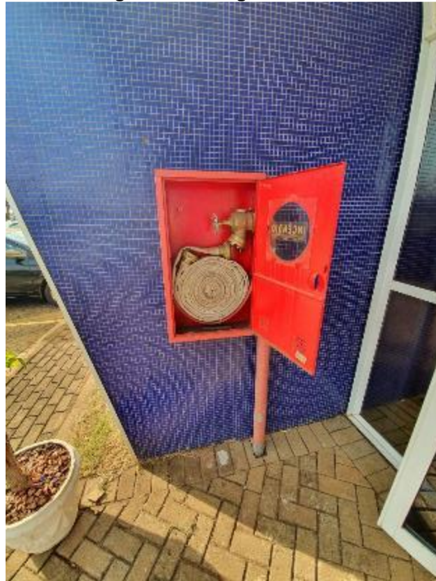
Imagem 44 – Abrigo de hidrante
