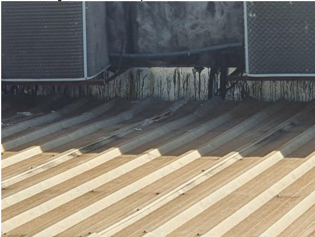
Imagem 61 – Cobertura Depósito de Urnas – Telhas amassadas
