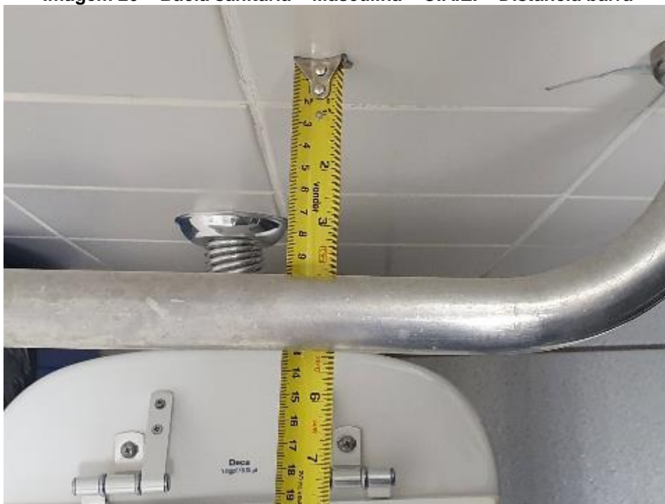
Imagem 20 – Bacia sanitária – Masculina – C.A.E. – Distancia barra
