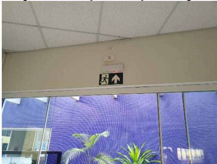
Imagem 39 – Sinalização e iluminação de emergência
