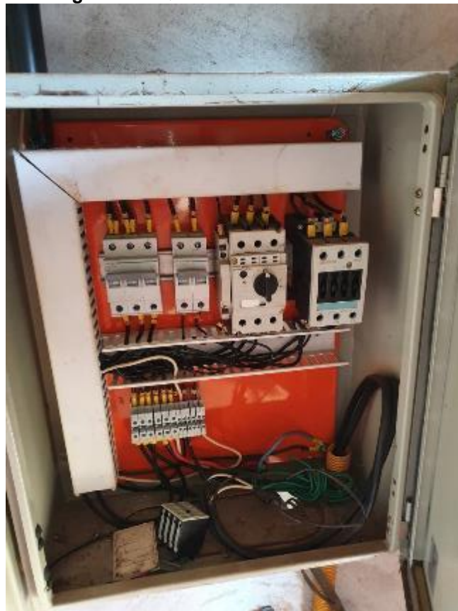
Imagem 45 – Quadro da Bomba de incêndio
