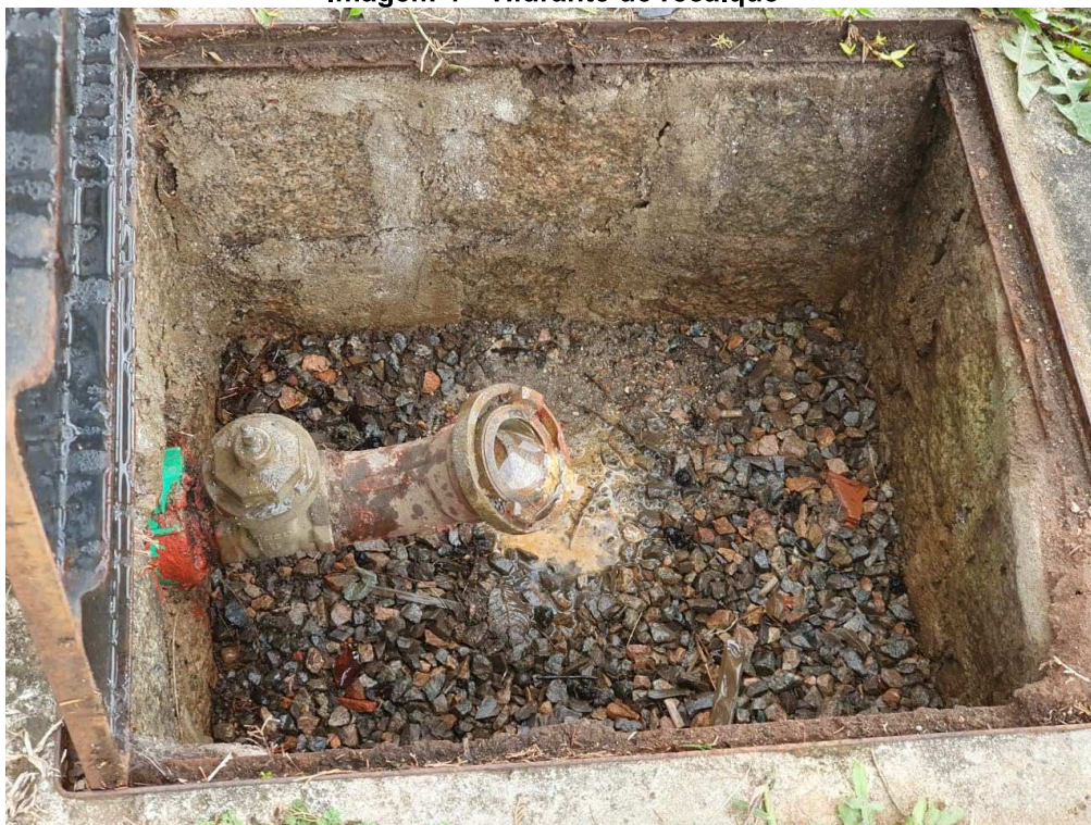
Imagem 4 – Hidrante de recalque
