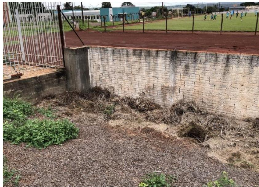
Com a ampliação do estacionamento um pequeno trecho de muro deve ter a altura ampliada, como também é preciso aterrinar o local, a estrutura desse trecho de muro deve ser reforçada para conter cargas accidentais oriundas de veículos e carga distribuída gerada pelo aterro e pavers.
