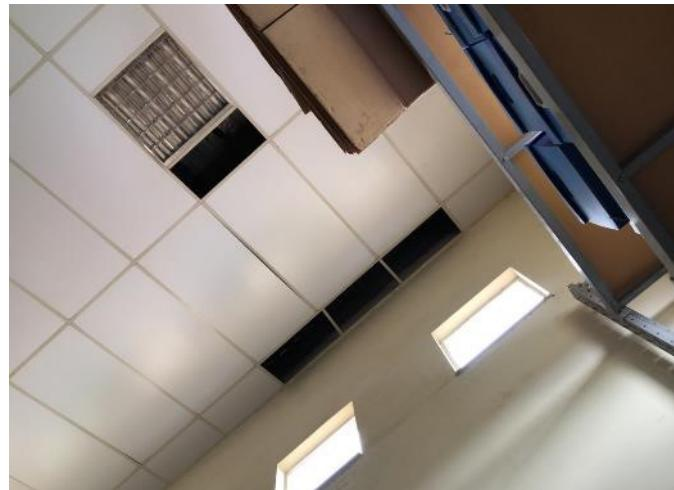
Por questões estéticas e de segurança da edificação, propõem-se a instalação das placas de forro faltantes, e encaixe das peças soltas utilizando-se da mesma estrutura existente e com o TRE-PR fornecendo as placas de forro que já foram adquiridas pela SMIN.
