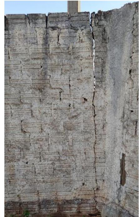
deformações ou fissuras, recomenda-se a demolição e reconstrução pontual do muro, inclusive com a execução de nova fundação e viga cinta.
