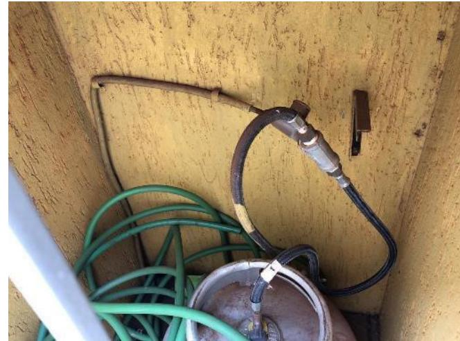
estanqueidade da tubulação, com emissão de laudo técnico indicando o perfeito funcionamento do sistema, instalação de abraçadeiras de fixação na tubulação, placas de sinalização – alerta, proibição e medida preventiva –, e extintor de incêndio em local próximo.
