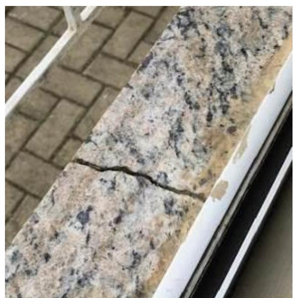
A vedação das janelas com selante também aparenta estar no final de sua vida útil, pois o selante está muito ressecado, precisando ser renovada para evitar o surgimento de novos pontos de infiltração.
