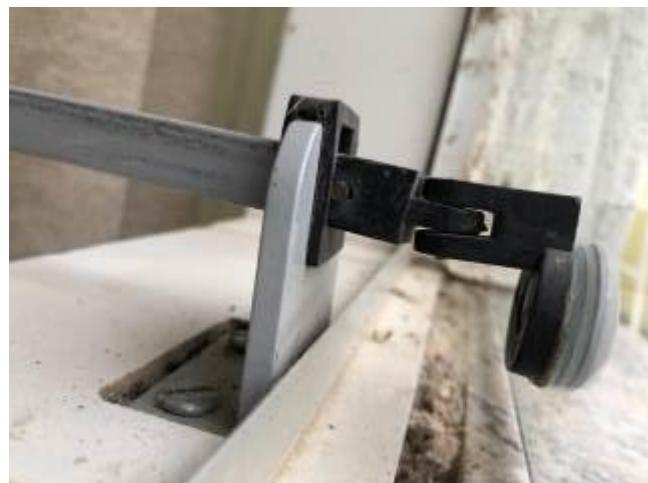
possibilitar o melhor funcionamento do sistema de abertura e fechamento e também reforçar a fixação dos parafusos do guia das hastes.
