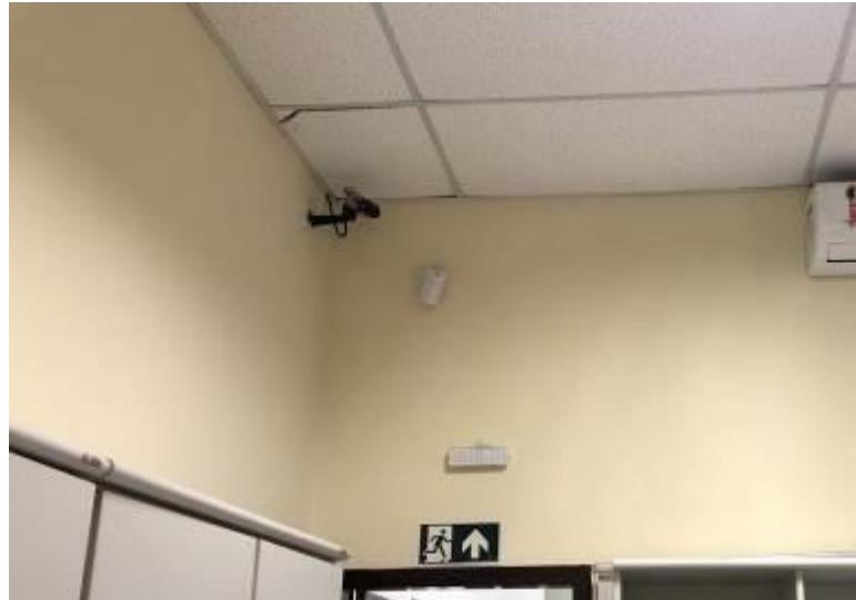
A equipe da SMIN vem fazendo a substituição completa do forro dos Fóruns Eleitorais por forro de PVC em placas. Por questões estéticas e em alguns pontos também de segurança dos ocupantes da edificação, propõem-se a substituição das placas de forro por forro do tipo PVC, utilizando-se da mesma estrutura existente e com o TRE-PR fornecendo as placas de forro, que já foram adquiridas pela SMIN.
