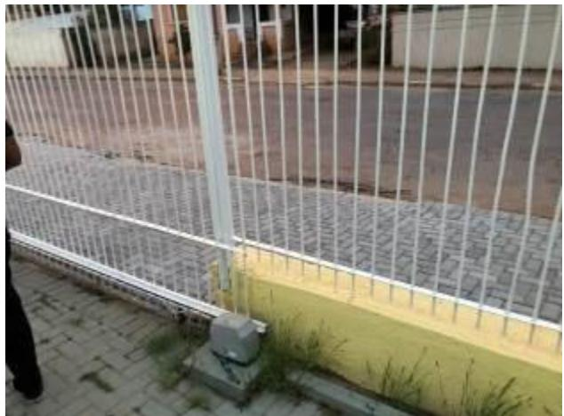
Aparentemente se trata de um vício no capacitor de partida do motor ou nos dentes da cremalheira e no eixo do motor deslizante, será preciso contratar a substituição dos dispositivos danificados.
