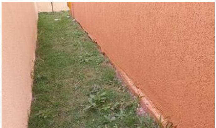
conta dos constantes alagamentos somados a falta de compactação do solo na época da construção. Esse recalque aparenta estar estabilizado e não indica riscos reais à estrutura, apenas prejudica esteticamente.
