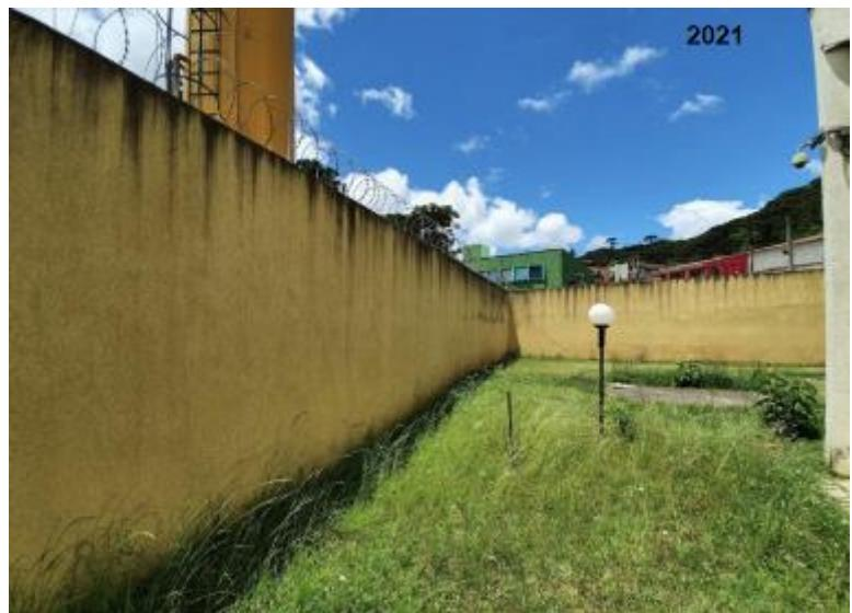
A melhor solução é instalar rufo de topo (capas de muro) sobre os muros para evitar o surgimento de novas manchas.
