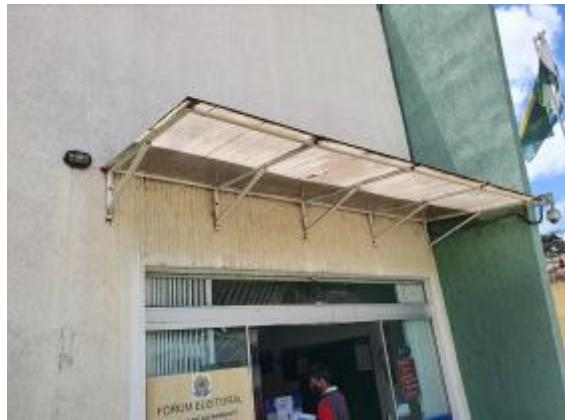
Para adequação do toldo da C.A.E. é preciso substituir as chapas de policarbonato alveolar por novas, recomenda-se trocar de alveolar para o modelo compacto, pois esse facilitará em muito a limpeza, pois não permite que a sujeira acumule sobre o toldo.
