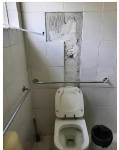
para deslocar as bacias sanitárias até as posições corretas, seguindo o padrão estipulado nas reformas anteriores de Fóruns Eleitorais, isso porque o restante do revestimento, tanto em parede quanto no piso apresenta bom estado de conservação, e a substituição completa do revestimento cerâmico acarretaria em alto custo e tempo de execução. Porém, é preciso ressaltar que, a depender de qual modelo cerâmico for adquirido existirá um pequeno contraste entre as peças novas e as antigas.
