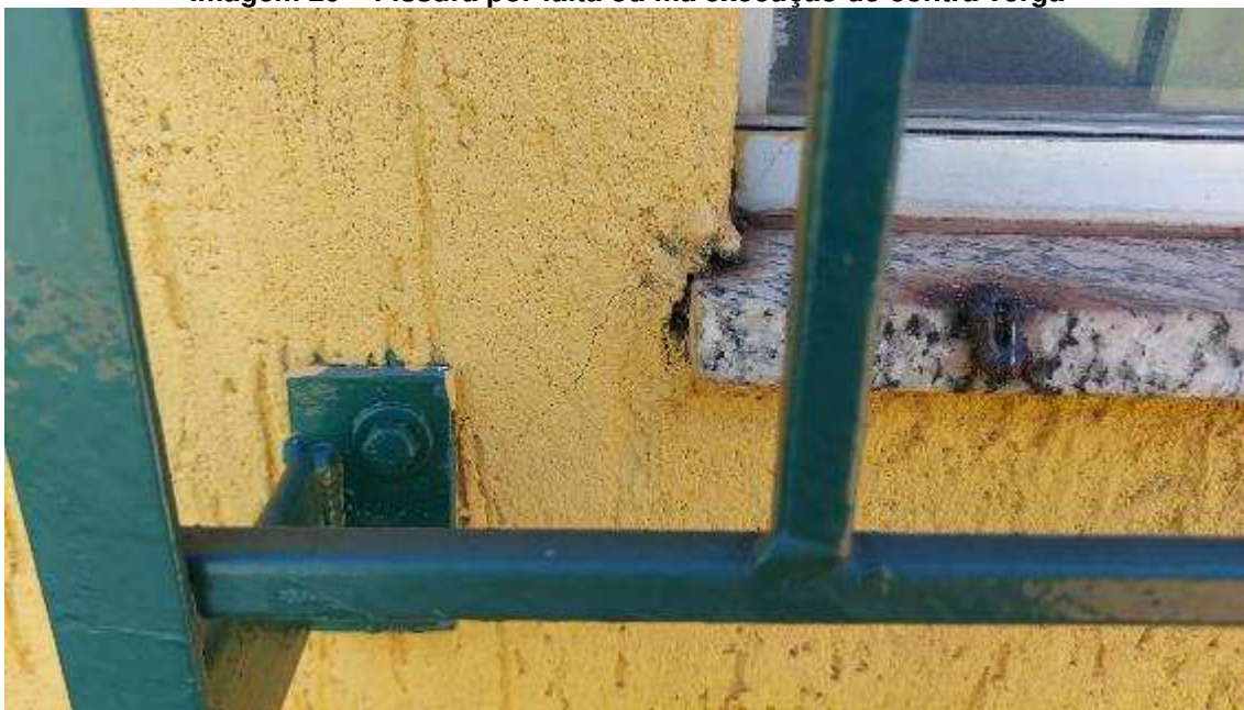
Imagem 29 – Fissura por falta ou má execução de contra verga
