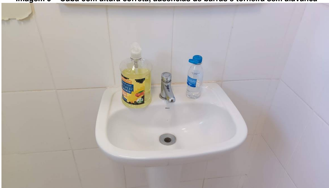
Imagem 9 – Cuba com altura correta, ausências de barras e torneira sem alavanca
