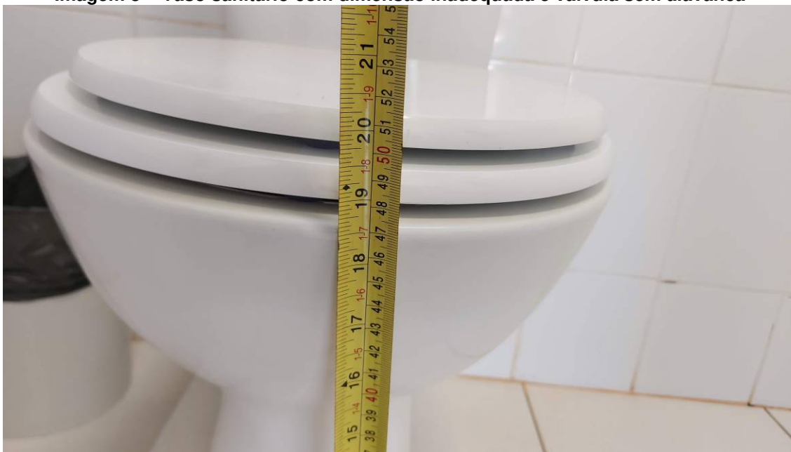
Imagem 8 – Vaso sanitário com dimensão inadequada e válvula sem alavanca
