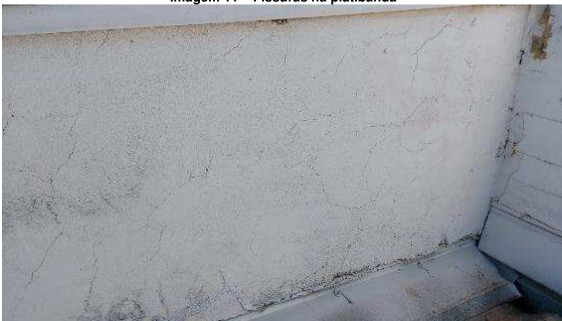
Imagem 11 – Fissuras na platibanda
