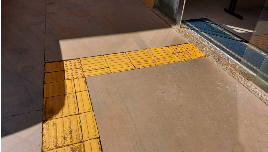
Imagem 5 – Piso tátil do fórum em desacordo com a NBR e acabamento precário
