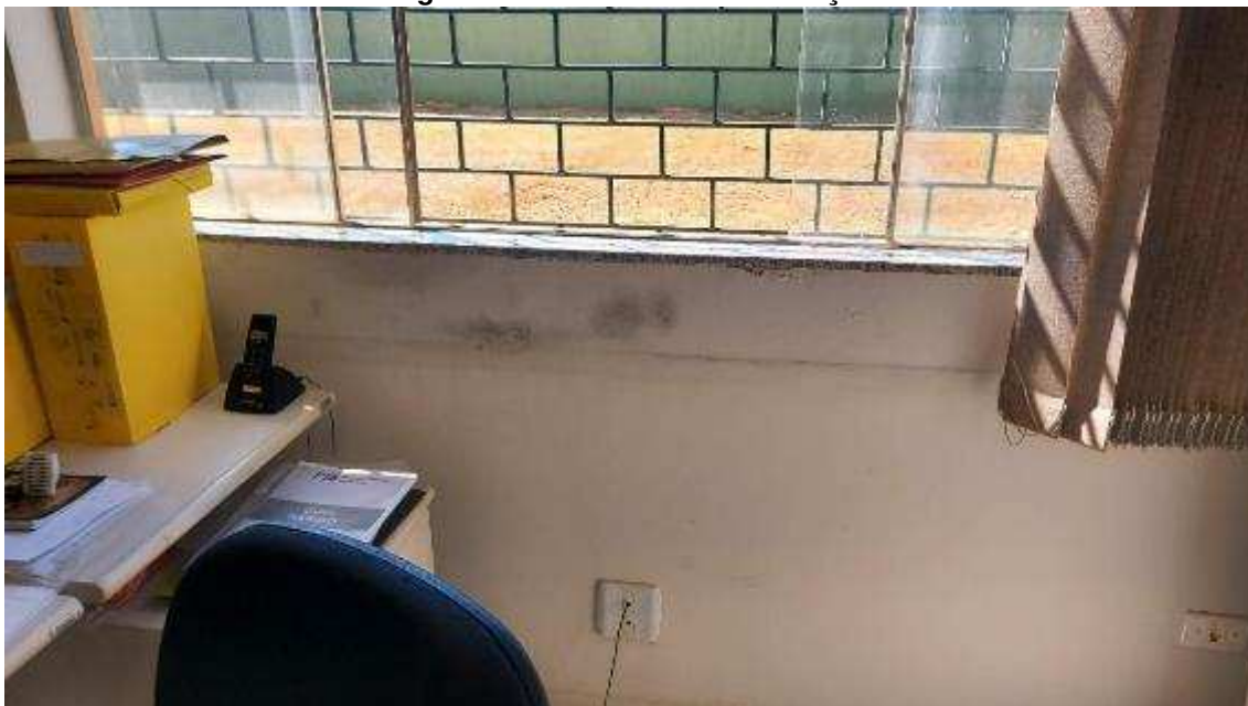
Imagem 26 – Janelas com infiltrações
