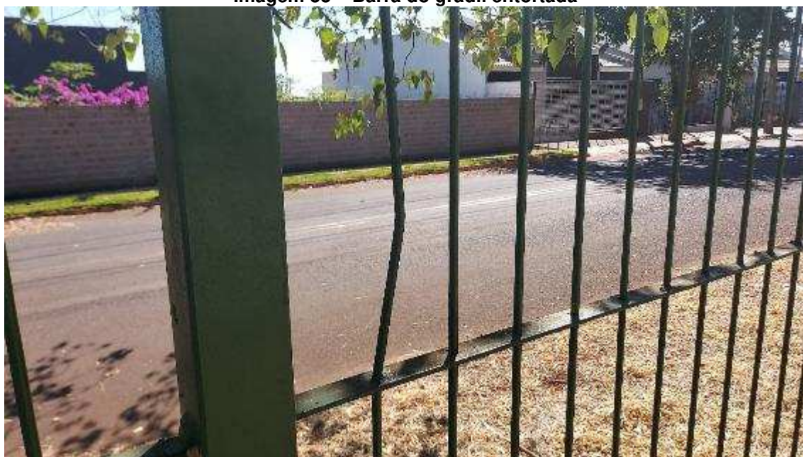
Imagem 33 – Barra do gradil entortada
