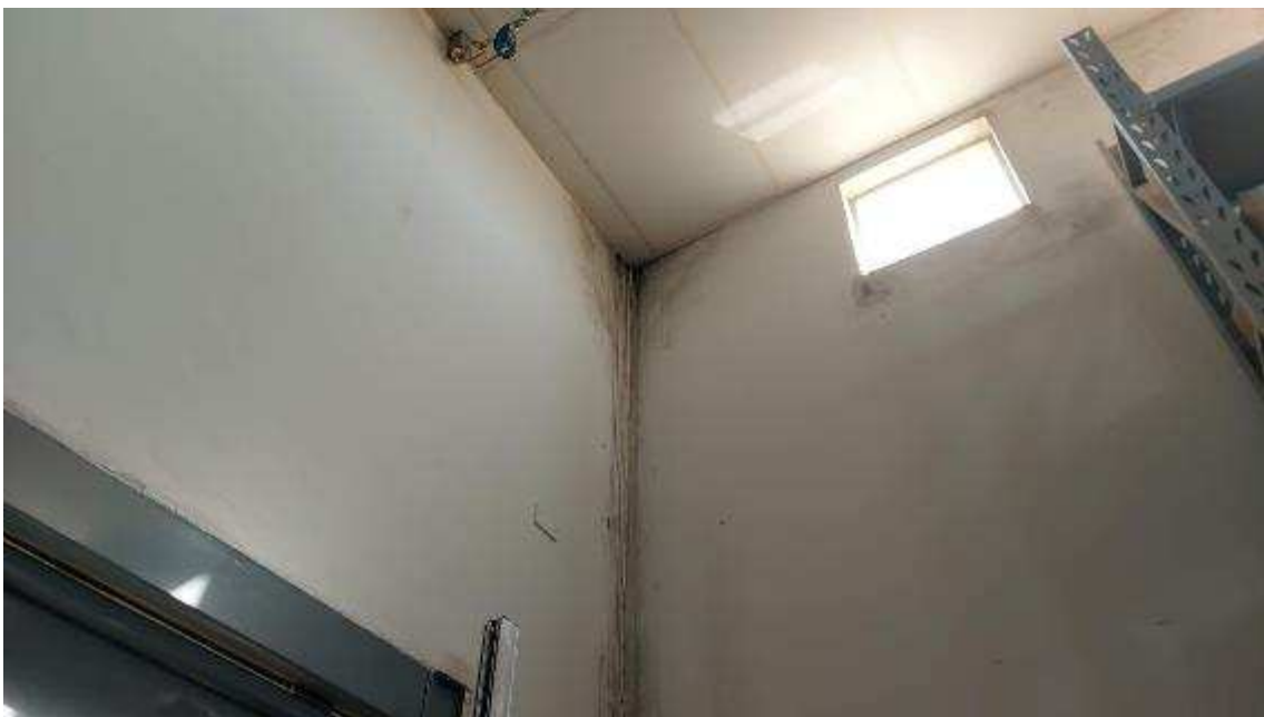
Imagem 19 – Infiltração no depósito de urnas
