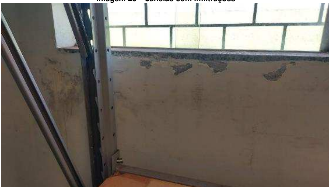
Imagem 25 – Janelas com infiltrações
