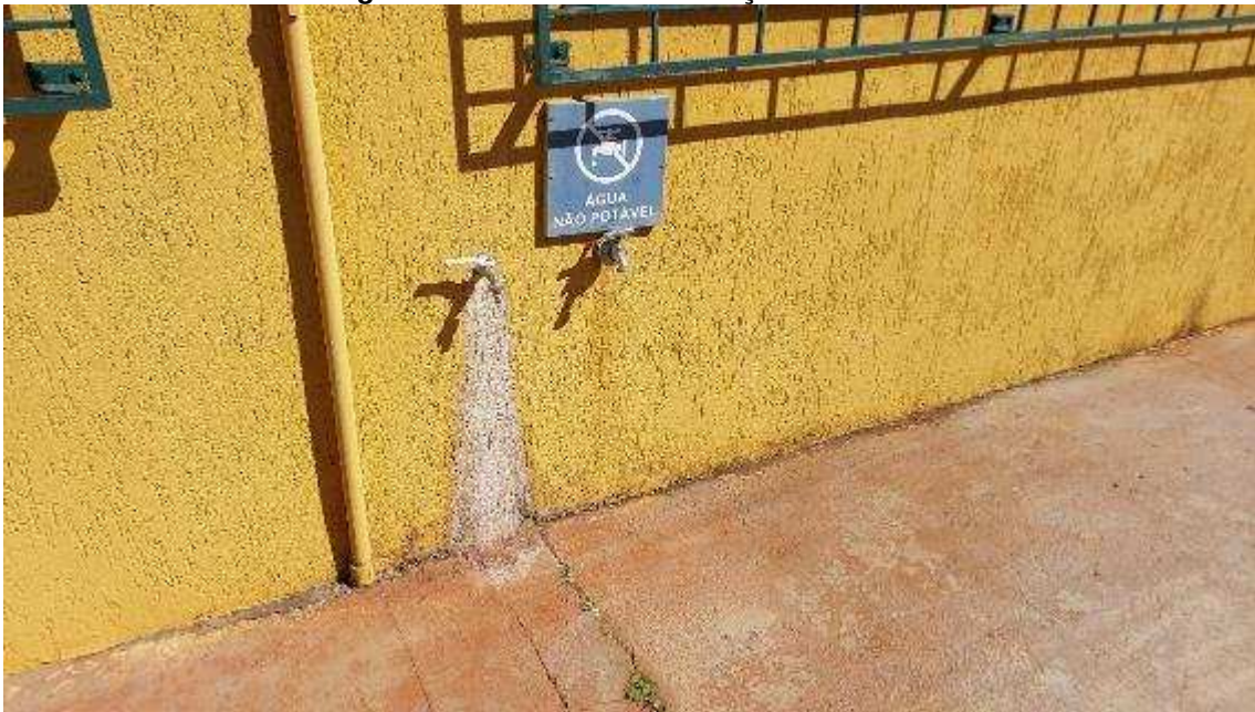
Imagem 42 – Mancha de infiltração na torneira
