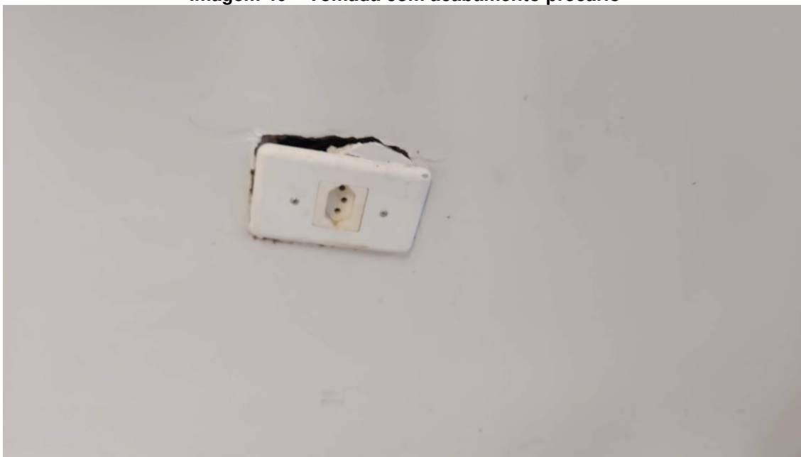
Imagem 40 – Tomada com acabamento precário
