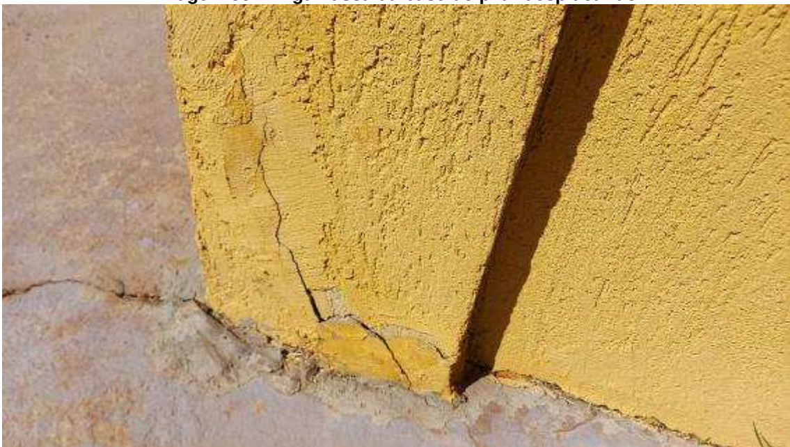
Imagem 35 – Argamassa da base do pilar deslocando
