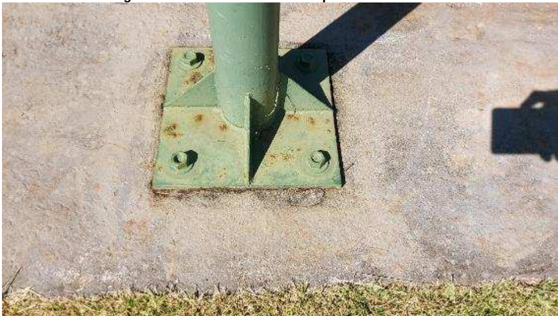
Imagem 39 – Base dos mastros em processo de corrosão
