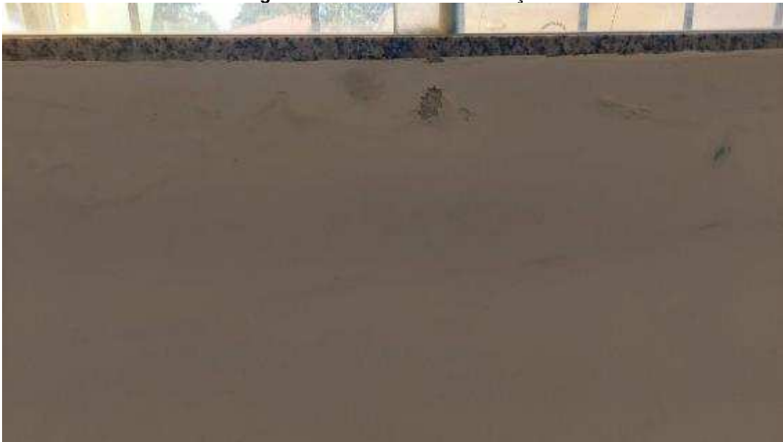
Imagem 23 – Janelas com infiltrações
