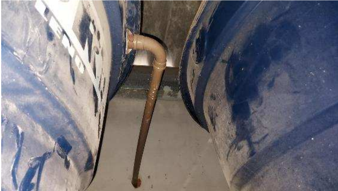
Imagem 37 – Vazamento na tubulação do ladrão da caixa d'água
