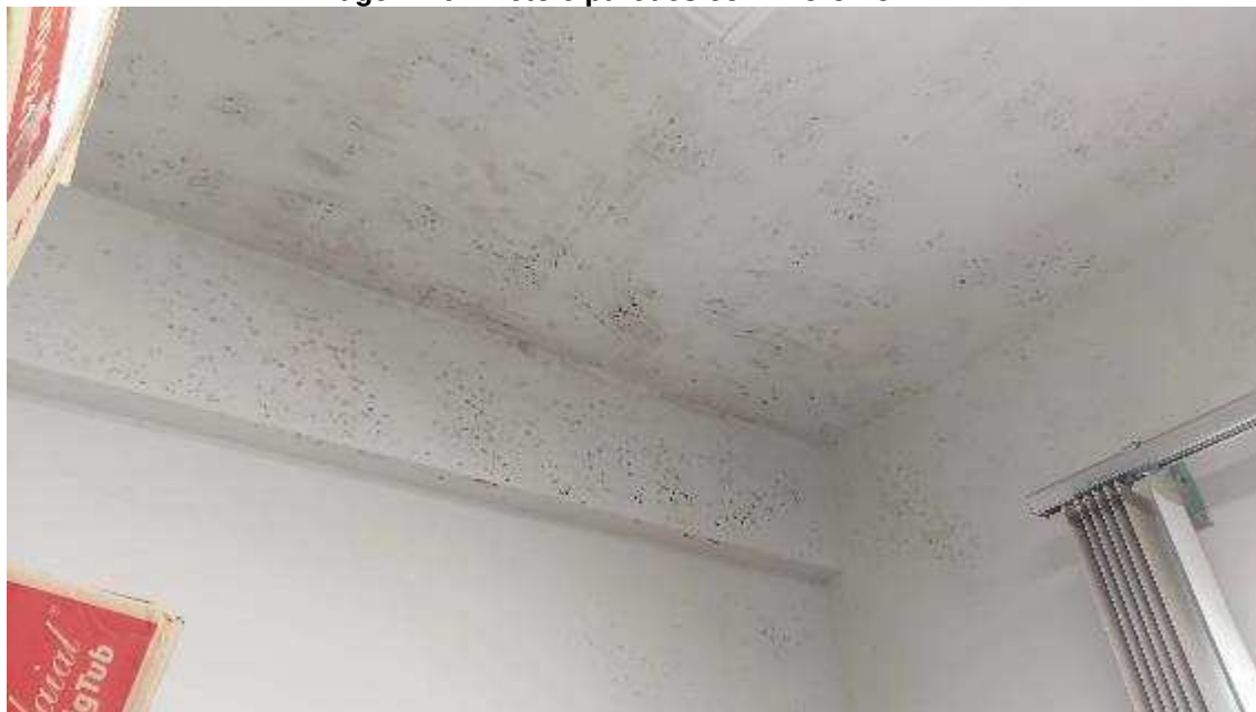
Imagem 20 – Teto e paredes com mofo no DML
