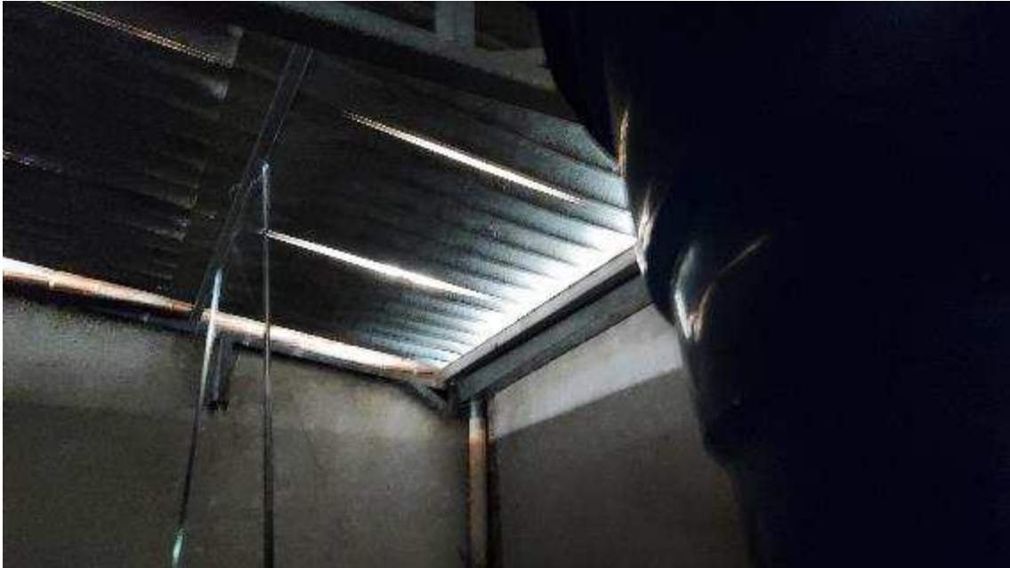
Imagem 18 – Telhas permitem a passagem de água
