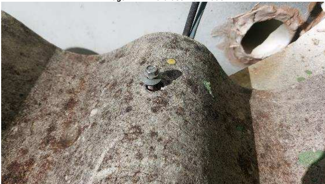
Imagem 14 – Parafuso mal fixado
