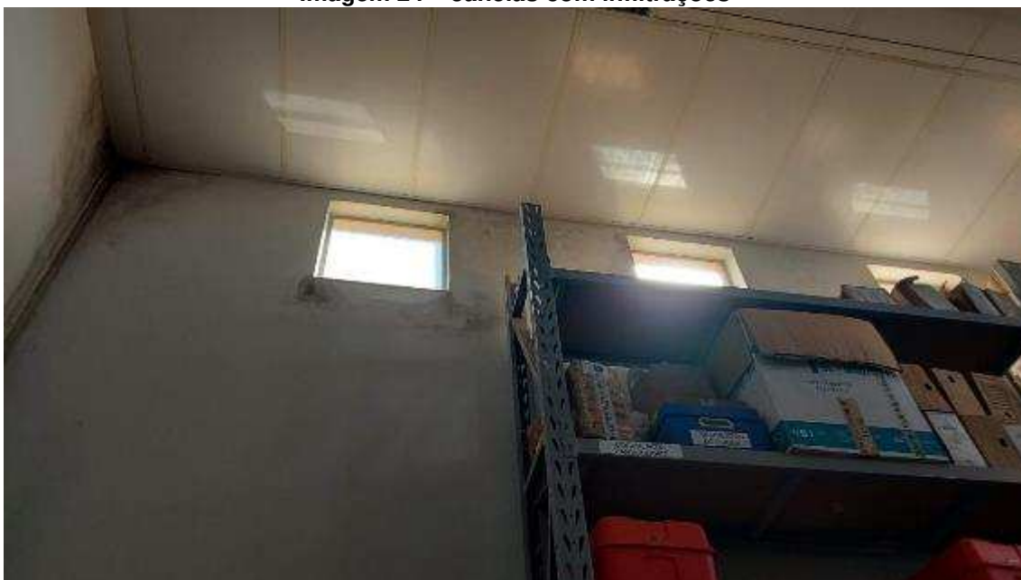
Imagem 24 – Janelas com infiltrações
