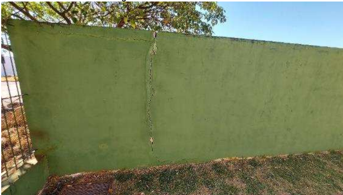
Imagem 30 – Muro com rachadura
