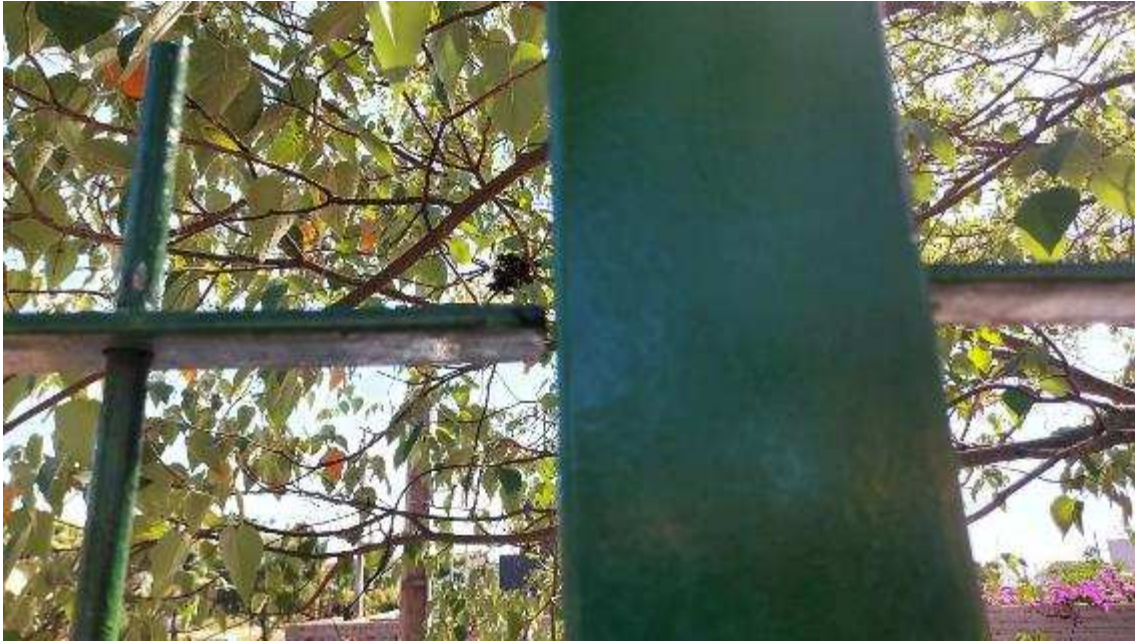
Imagem 34 – Falta de ligação entre pilar do gradil e barra
