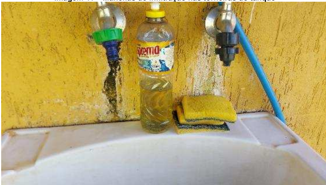
Imagem 41 – Manchas de infiltração nas torneiras do tanque
