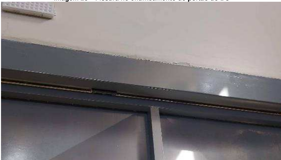
Imagem 28 – Fissura no chumbamento do portão do DU
