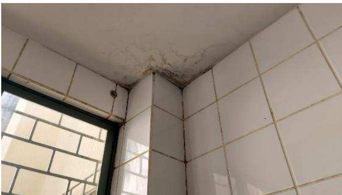
Infiltração no teto do banheiro feminino da CAE
