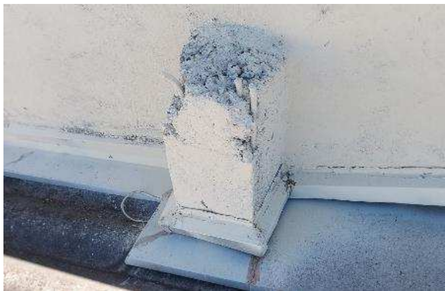
Pilar com armadura exposta
