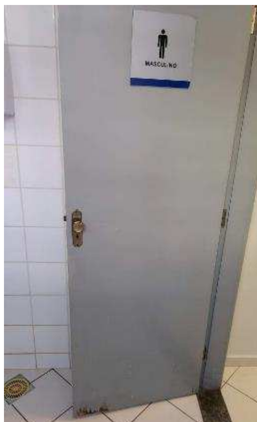
Porta e maçaneta em desconformidade com a norma
