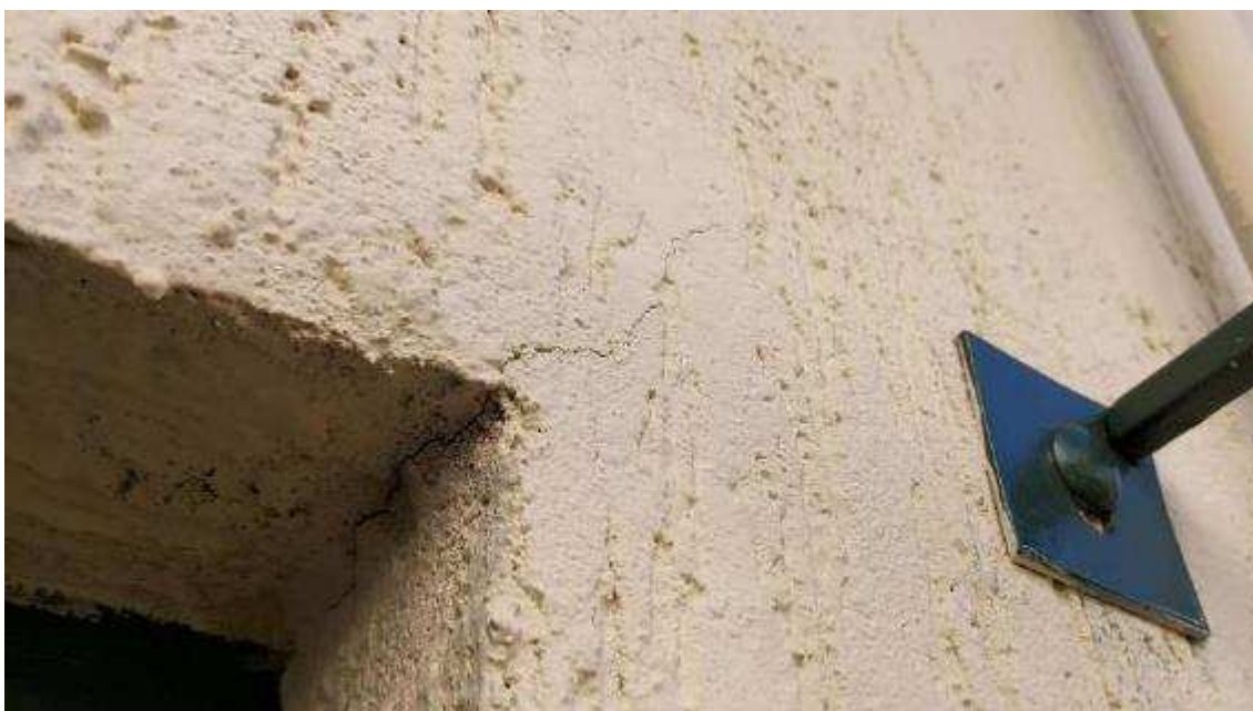
Fissura característica da ausência ou má execução de verga
