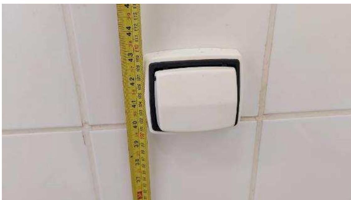
Altura e tipo de válvula de descarga em desconformidade com a norma
