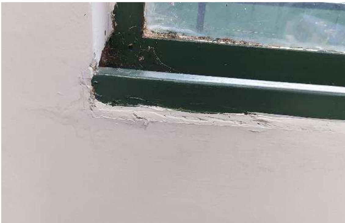
Janela com mancha de infiltração
