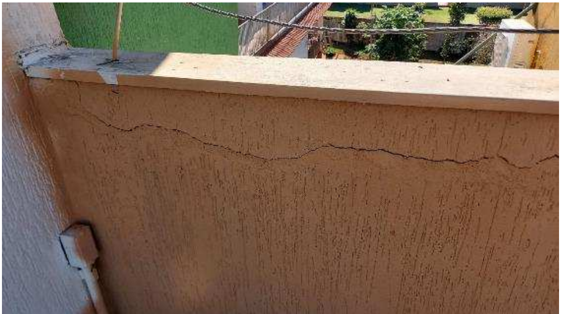
Fissuração na platibanda da cobertura
