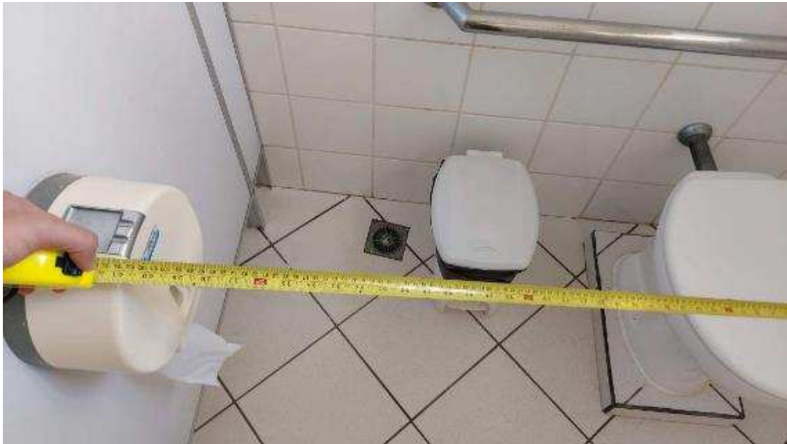
Altura da colocação da papelreira e posicionamento em desconformidade com a norma
