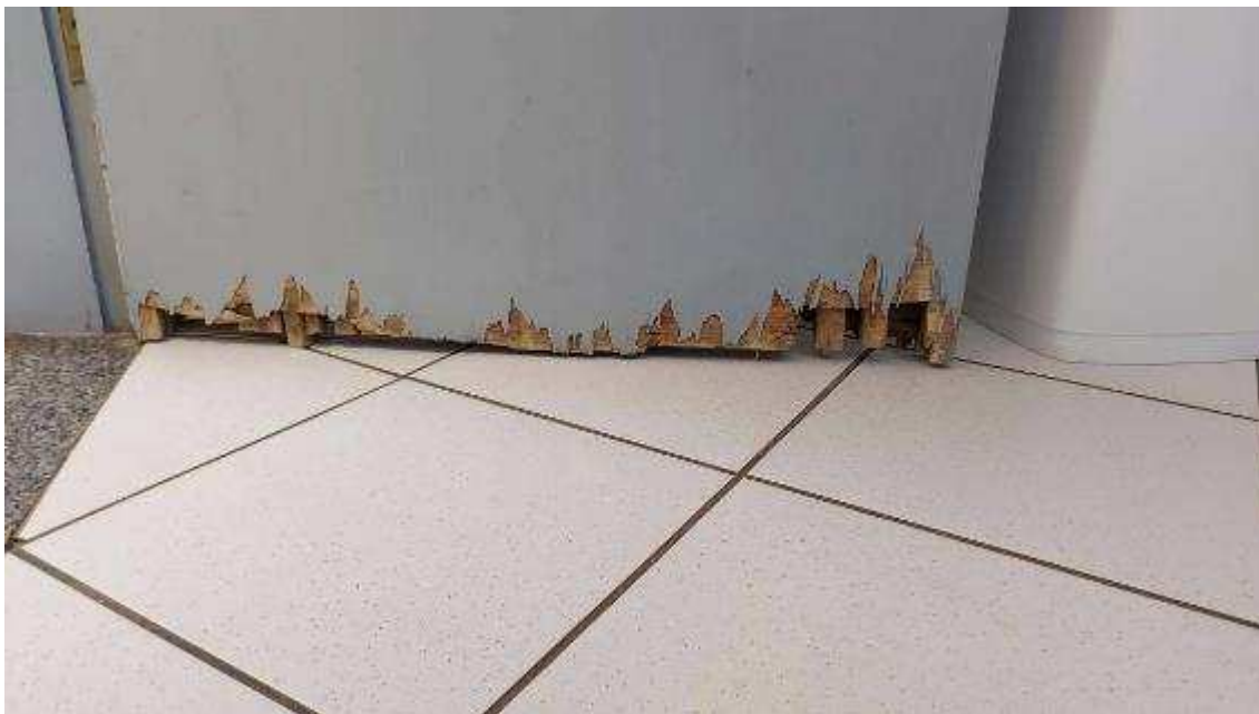
Portas danificadas na parte inferior
