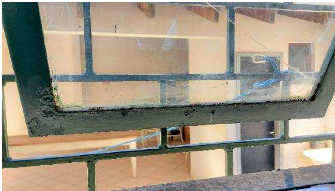
Janela com corrosão no perfil
