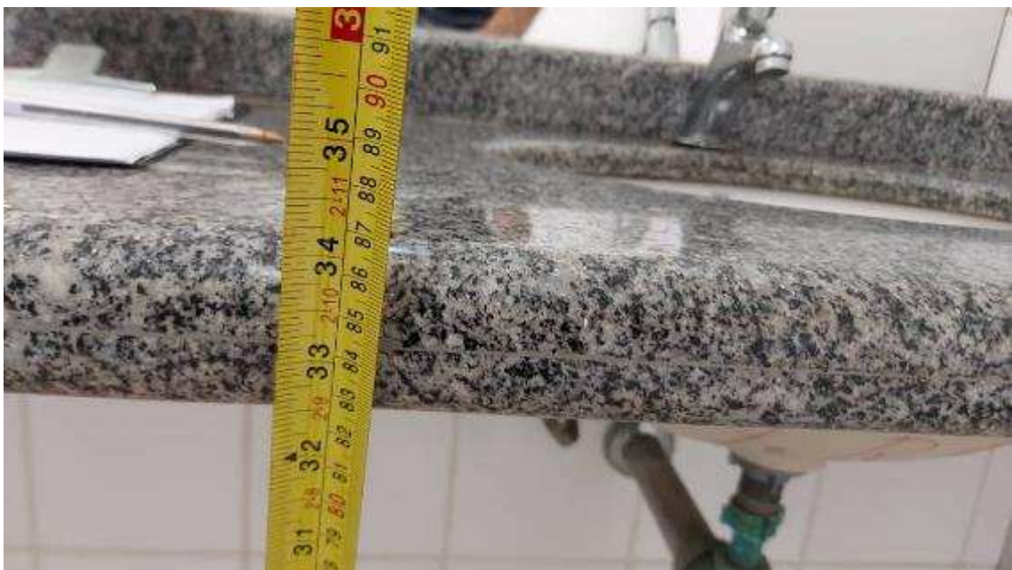
Altura e tipo do lavatório em desconformidade com a norma
