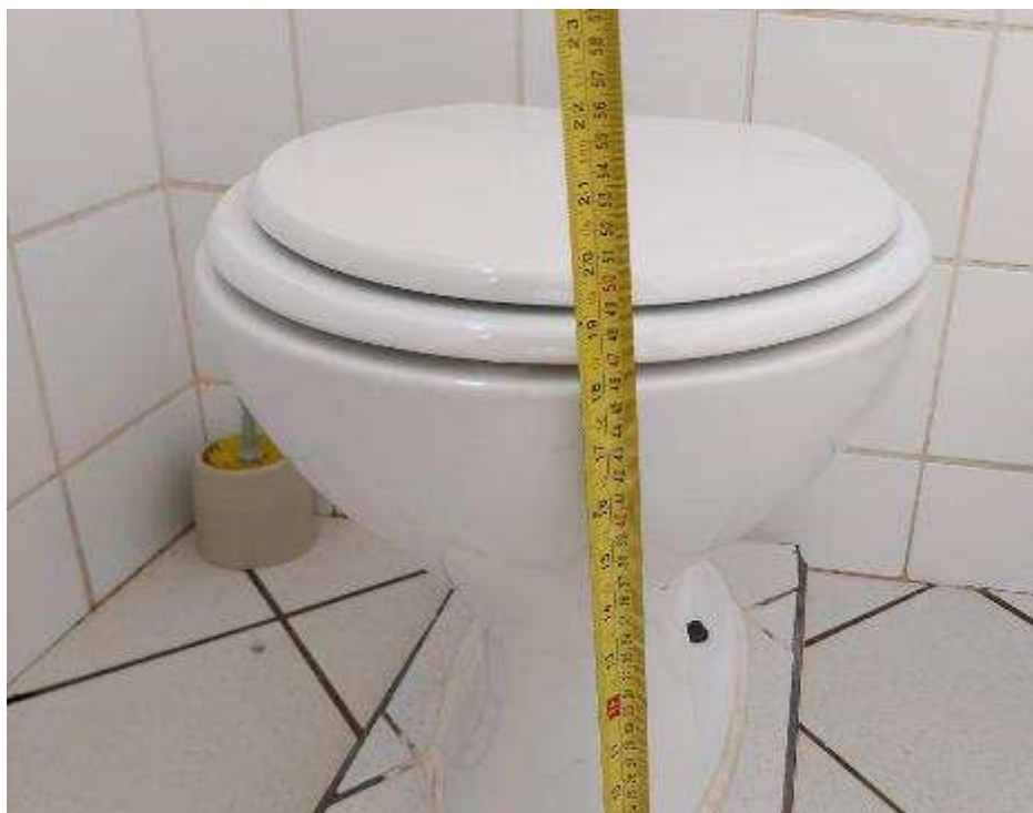
Altura do vaso sanitário em desconformidade com a norma
