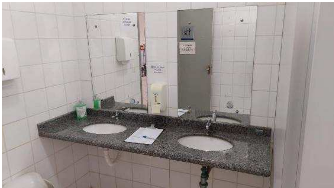
Inexistência de barras no lavatório e papeleira com altura desconforme com a norma
