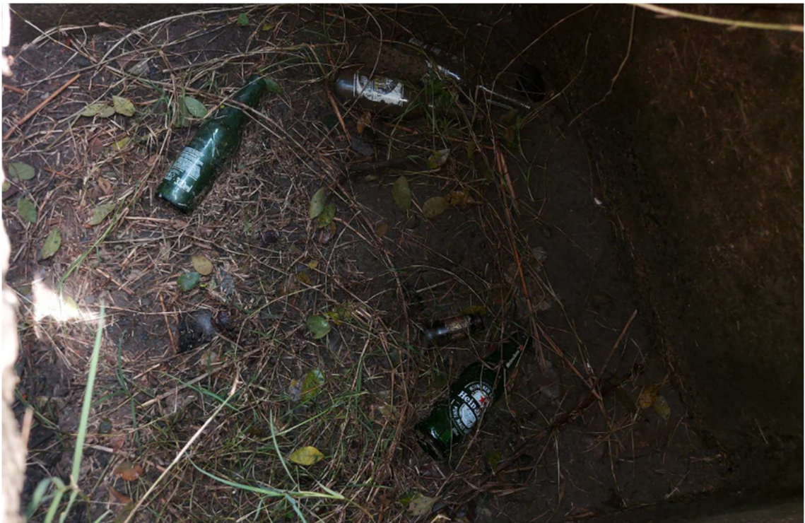
Galeria de águas pluviais com lixo acumulado
