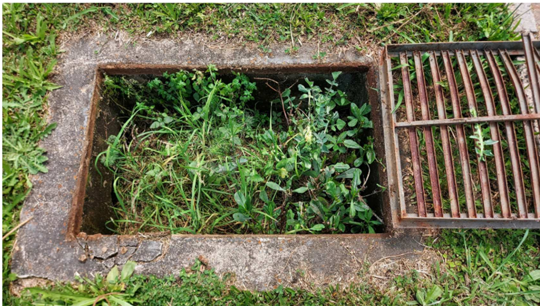
Caixa de águas pluviais tomada pela vegetação
