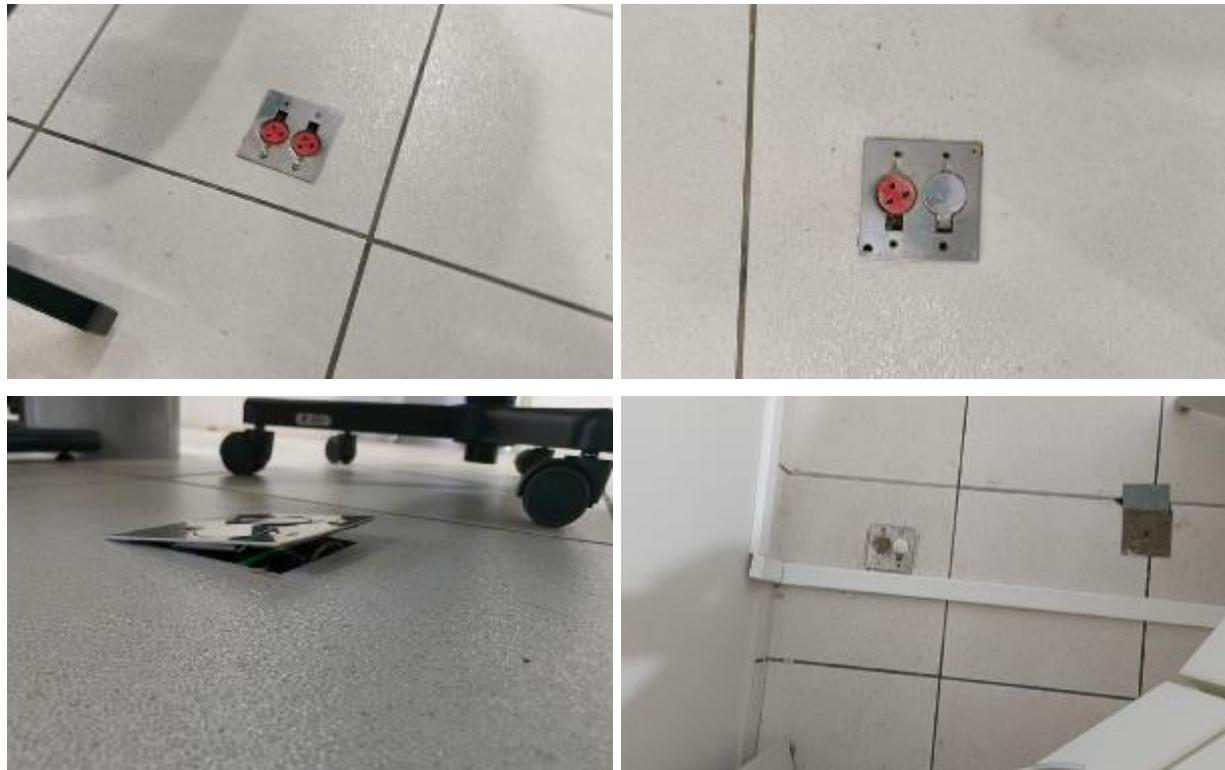
A fim de manter os pontos de tomada no piso da C.A.E. em funcionamento, e garantir a segurança e a vida útil das instalações novas tampas de tomada deverão ser instaladas, substituindo aquelas danificadas.
