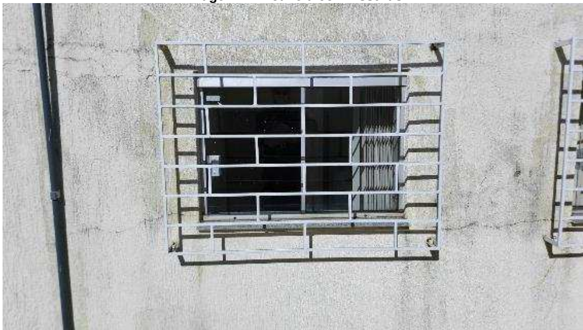
Imagem 24 – Janela com fissuras
