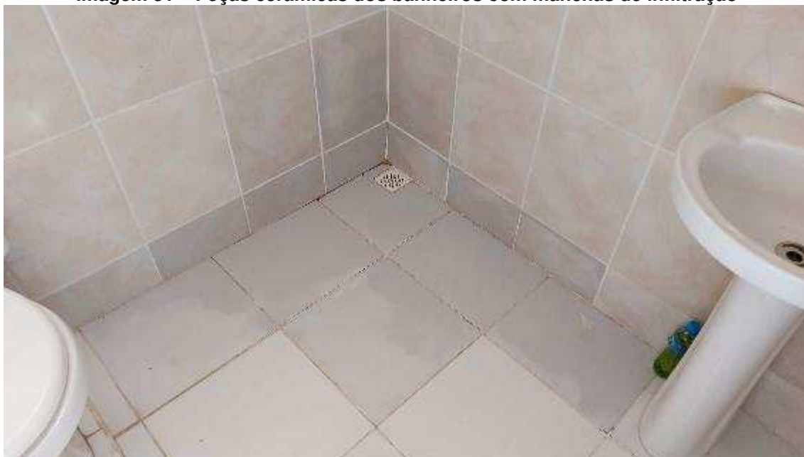
Imagem 31 – Peças cerâmicas dos banheiros com manchas de infiltração
