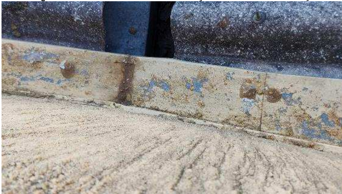
Imagem 14 – Chumbamento do contra rufo com fissuras
