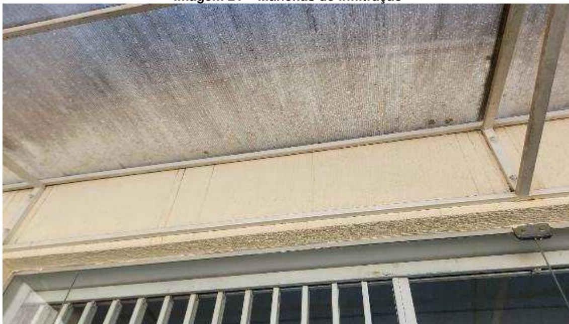
Imagem 21 – Manchas de infiltração
