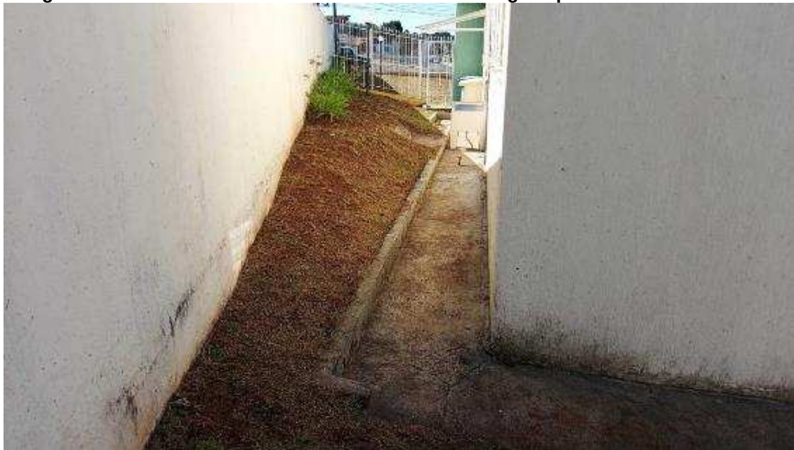
Imagem 30 – Fórum está em nível mais baixo e recebe águas pluviais do terreno vizinho
