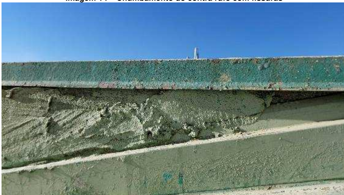
Imagem 14 – Chumbamento do contra rufo com fissuras
