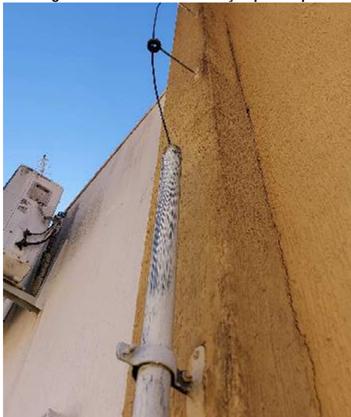
Imagem 39 – Fissura na platibanda
