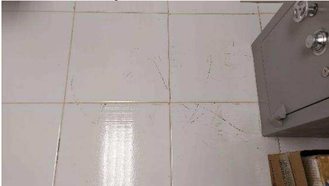
Imagem 43 – Piso cerâmico riscado
