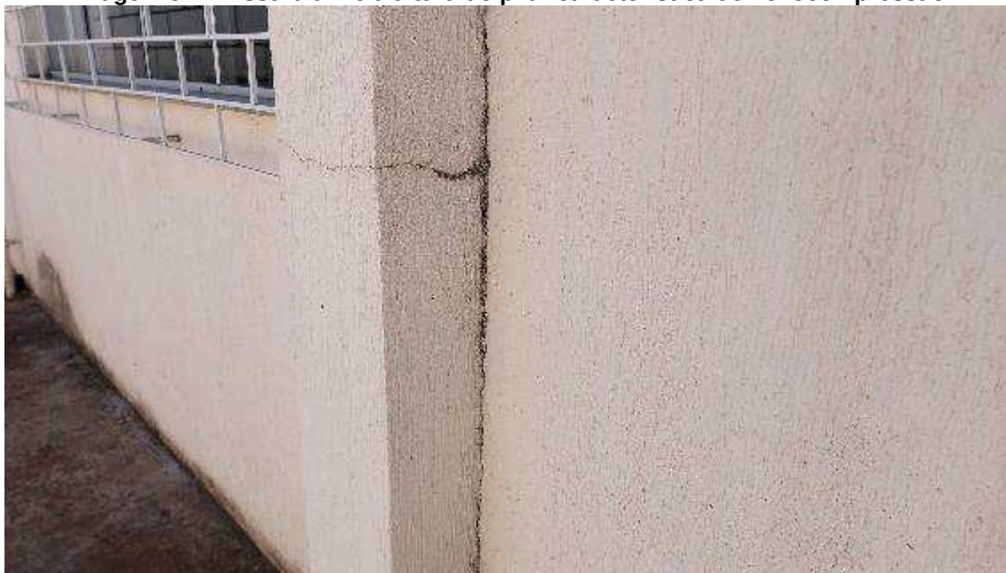
Imagem 34 – Fissura a meia altura do pilar característica de flexocompressão
