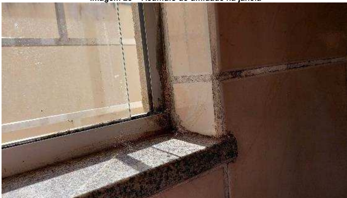
Imagem 26 – Acúmulo de umidade na janela
