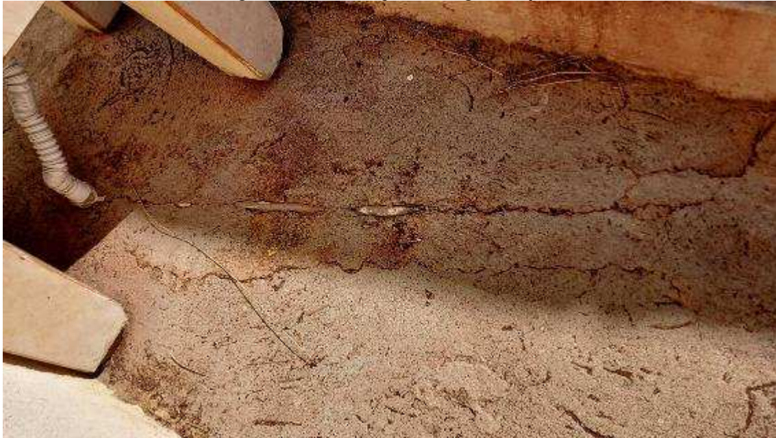
Imagem 40 – Tubulação de esgoto exposta
