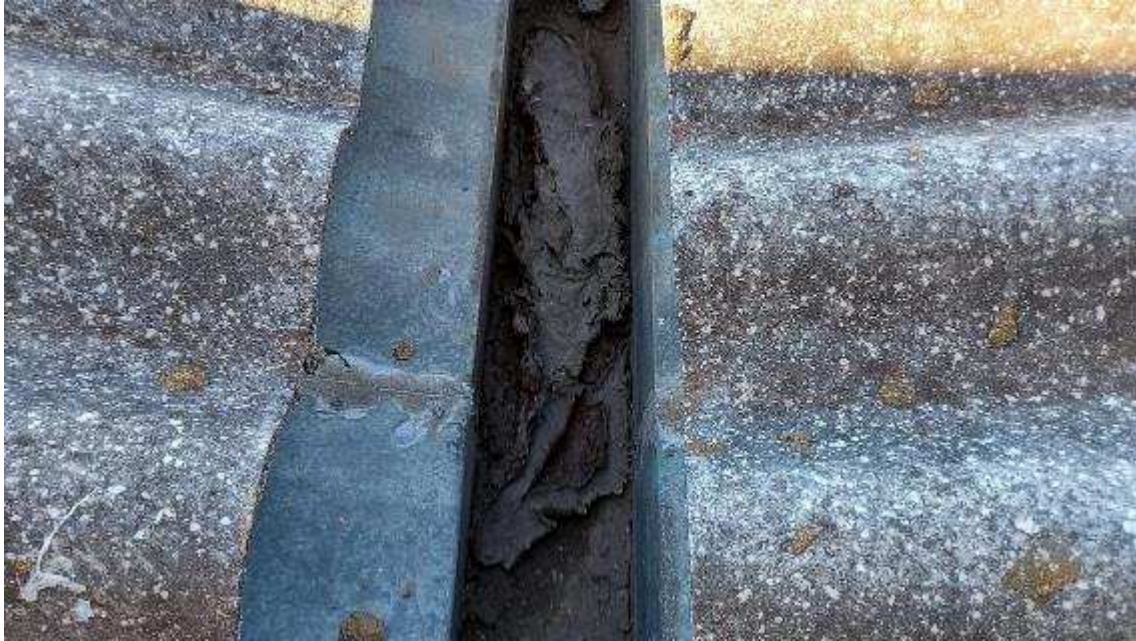
Imagem 11 – Calhas sujas e subdimensionadas
