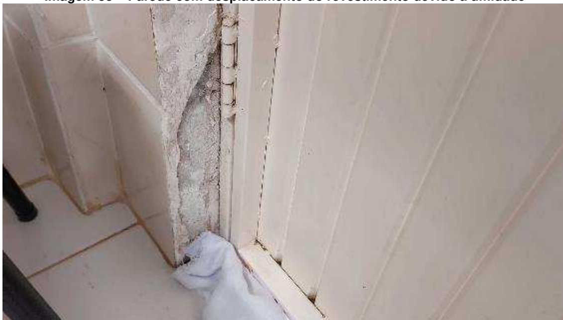
Imagem 33 – Parede com deslocamento do revestimento devido à umidade
