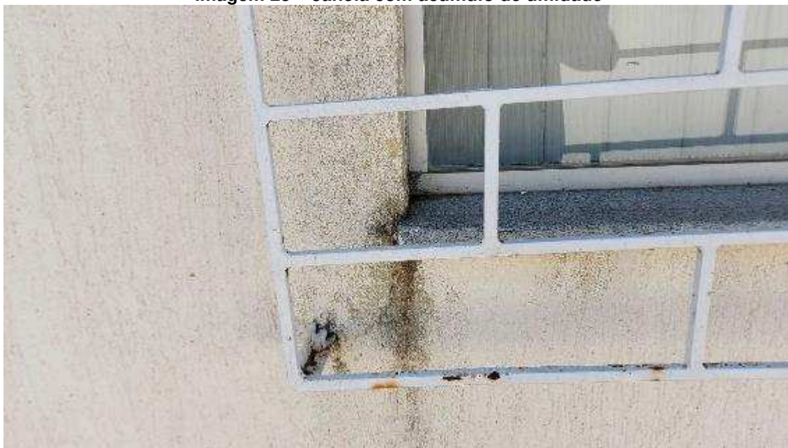
Imagem 26 – Acúmulo de umidade na janela
