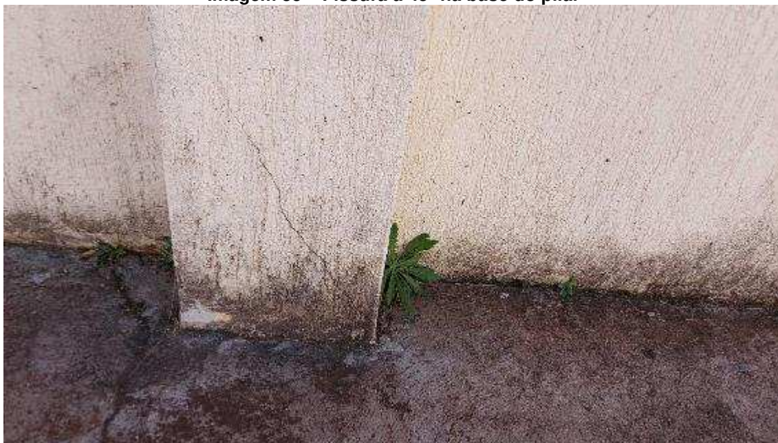
Imagem 35 – Fissura à 45° na base do pilar
