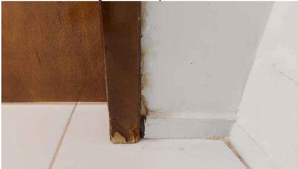
Imagem 33 – Parede com deslocamento do revestimento devido à umidade
