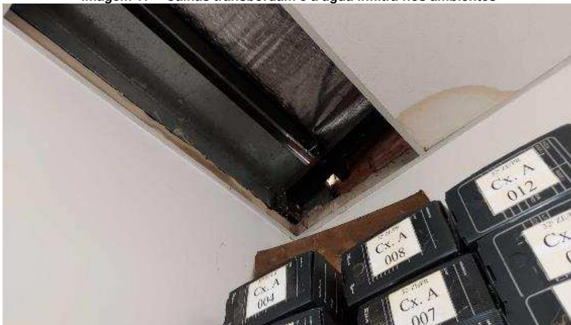
Imagem 17 – Calhas transbordam e a água infiltra nos ambientes
