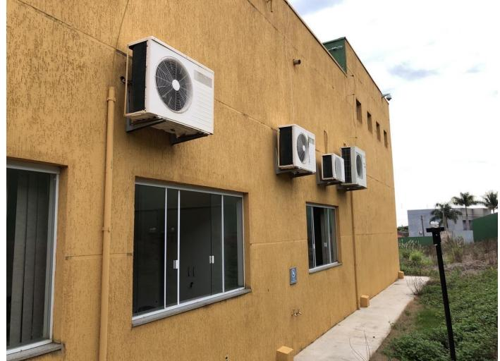
Dessa forma, recomenda-se a instalação de drenos fixados na alvenaria que seguem até o gramado.
