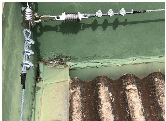
Recomenda-se a instalação dos rufos de forma correta e revisão geral da cobertura, considerando a substituição de todas as telhas danificadas e também a troca das vedações dos parafusos. Considerando o estado dos rufos e calhas existentes é possível executar os serviços com o reaproveitamento do material.
