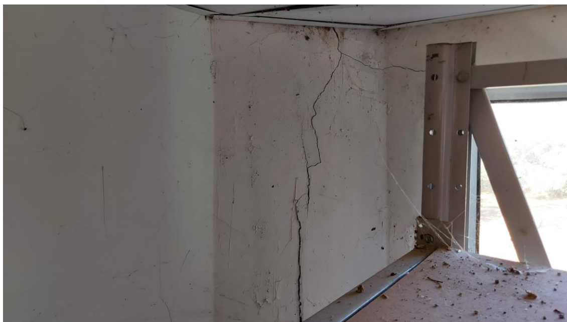
Imagem 9 – Fissura no fechamento da descida pluvial
