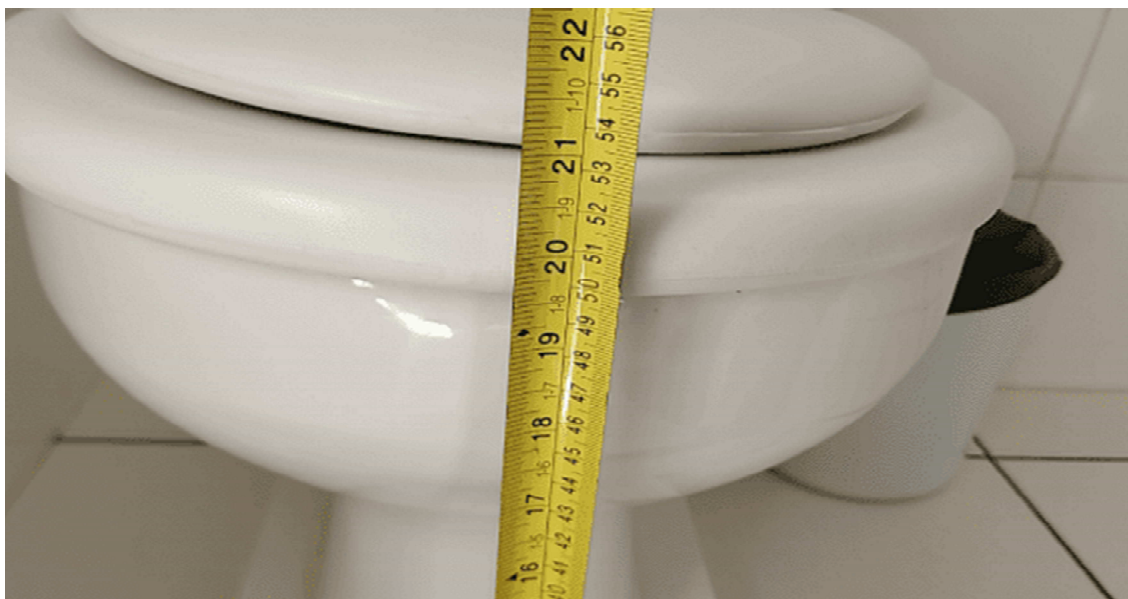
Imagem 5 – Vaso sanitário com altura desconforme
