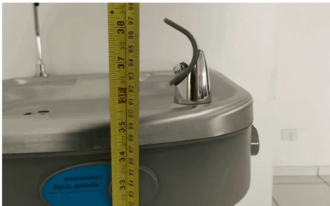
Imagem 4 – Bebedouro com altura desconforme
