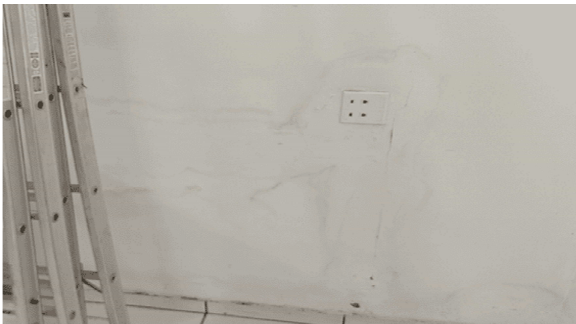
Imagem 21 – Manchas de infiltração
