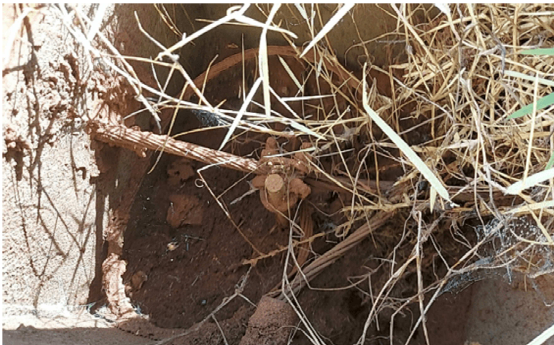
Imagem 31 – Caixa de inspeção SPDA com vegetação
