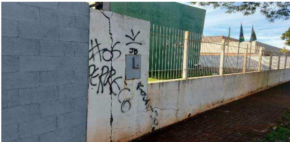
Imagem 6 – Muro com rachadura
