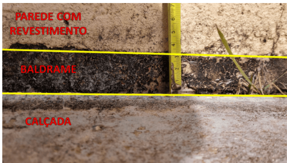
Imagem 27 – Afundamento do piso
