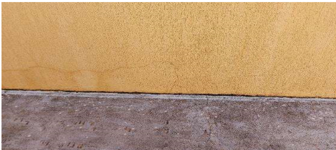
Imagem 18 – Fissuras na base da parede
