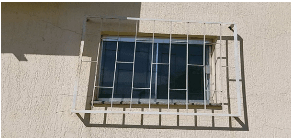
Imagem 19 – Falha/Falta de verga e contra verga
