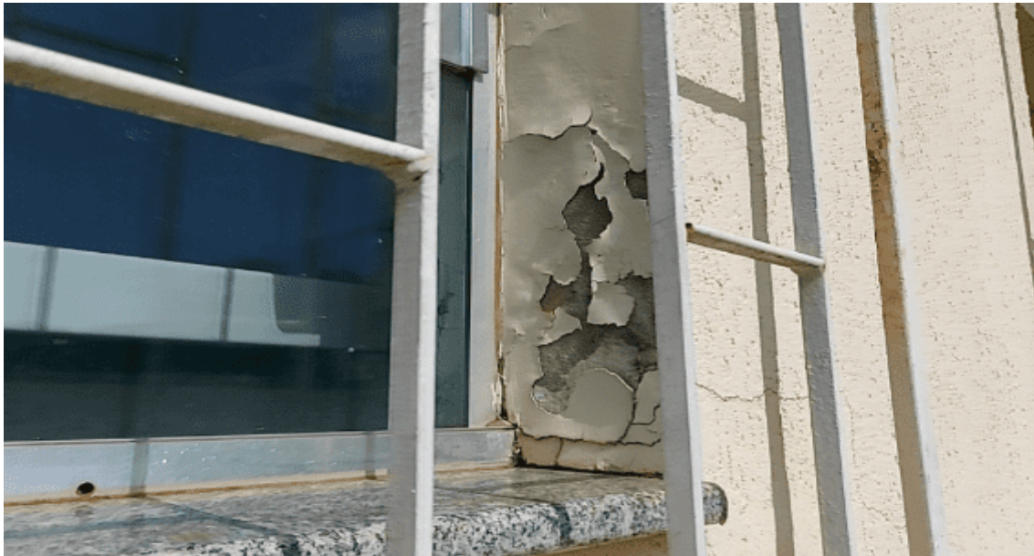
Imagem 8 – Pintura descascando
