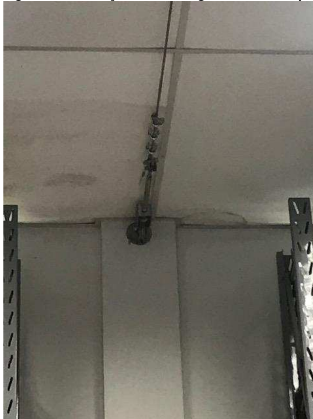
Imagem 9 – Instalação de ancoragem interna em pilar
