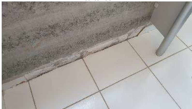
Imagem 163 – Trecho de rodapé faltando no sanitário feminino do lado esquerdo no piso dos cartórios
