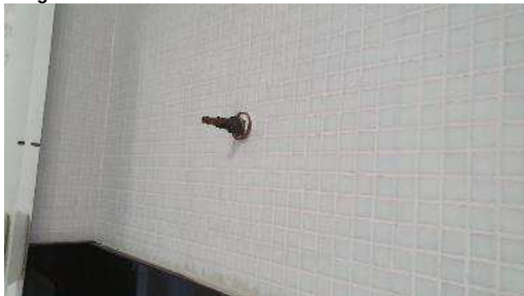
Imagem 172 – Registro sem acabamento – Sanitário masculino do Pavimento Superior
