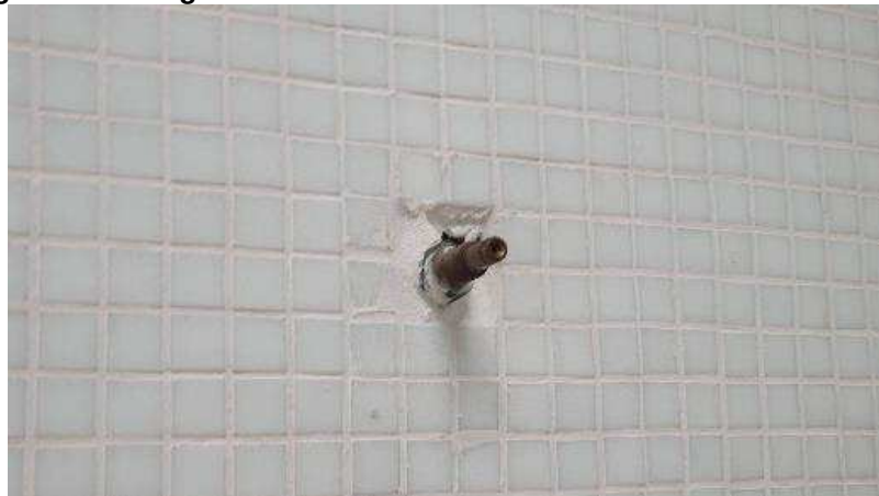
Imagem 135 – Registro sem acabamento no sanitário acessível da C.A.E.
