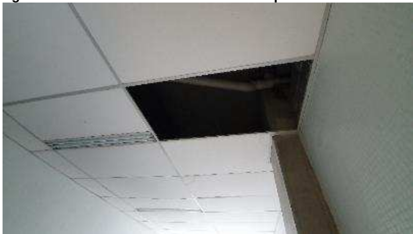
Imagem 161 – Forro faltante – Sanitários do pavimento dos cartórios
