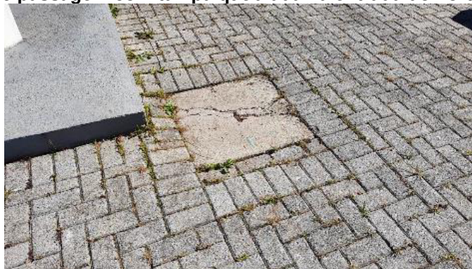
Imagem 113 – Caixa de passagem com tampa quebrada na entrada do Fórum Eleitoral de Curitiba
