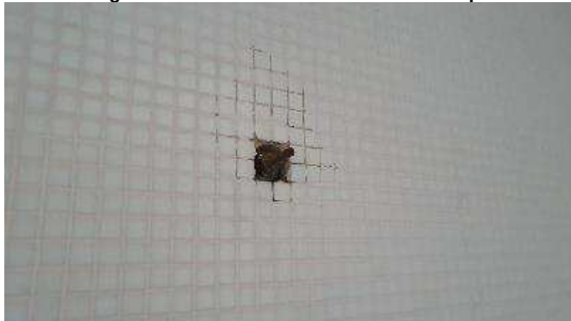
Imagem 156 – Registro sem acabamento – Sanitários do pavimento Térreo
