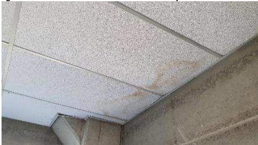
Imagem 162 – Forro manchado – Sanitários do pavimento dos cartórios
