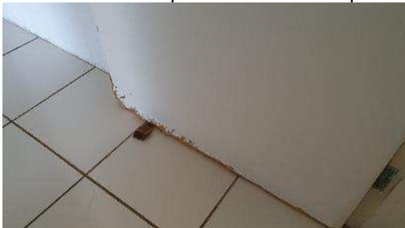
Imagem 153 – Portas com defeitos por umidade – Sanitários do pavimento Térreo
