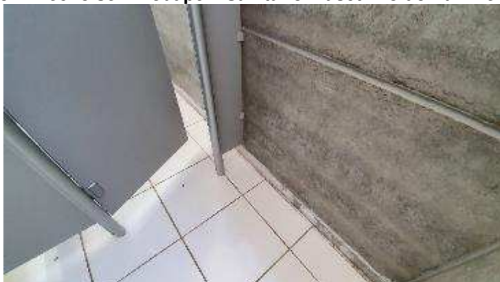
Imagem 173 – Trecho sem Rodapé – Sanitário masculino do Pavimento Superior
