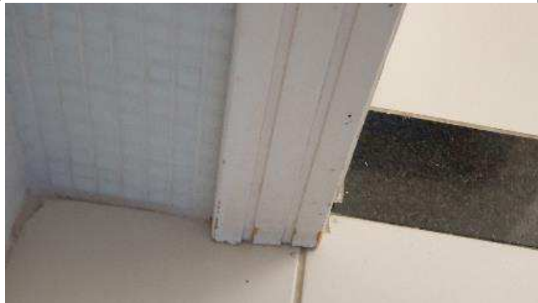
Imagem 169 – Batentes danificados – Sanitários do Pavimento Superior
