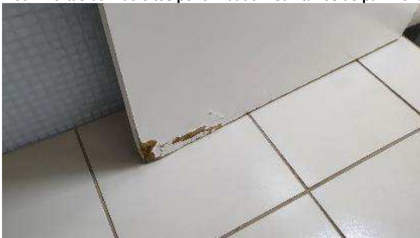
Imagem 155 – Portas com defeitos por umidade – Sanitários do pavimento Térreo
