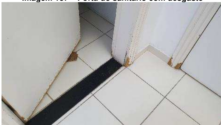
Imagem 137 – Porta do sanitário com desgaste
