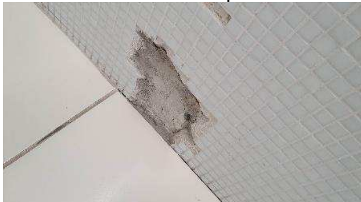
Imagem 142 – Defeito do revestimento cerâmico da parede no sanitário feminino da C.A.E.
