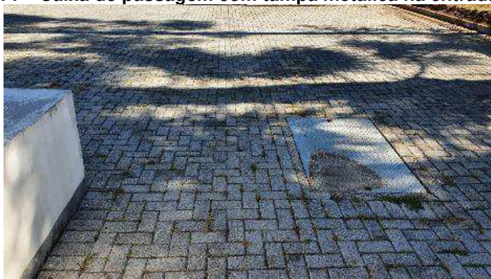
Imagem 114 – Caixa de passagem com tampa metálica na entrada do Fórum
