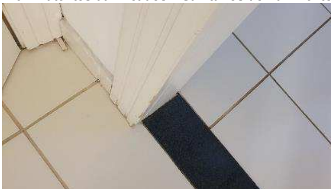
Imagem 170 – Batentes danificados – Sanitários do Pavimento Superior
