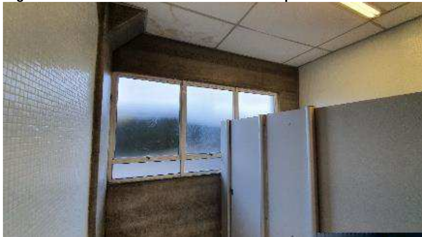
Imagem 160 – Forro manchado – Sanitários do pavimento dos cartórios
