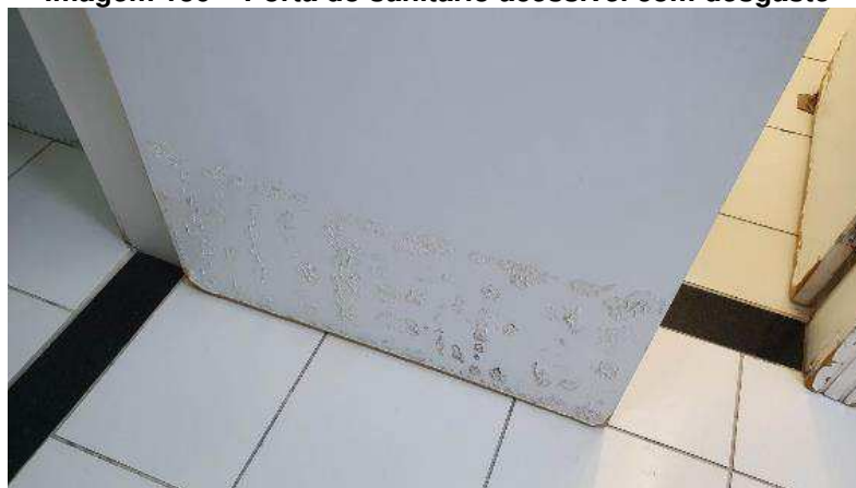
Imagem 136 – Porta do sanitário acessível com desgaste
