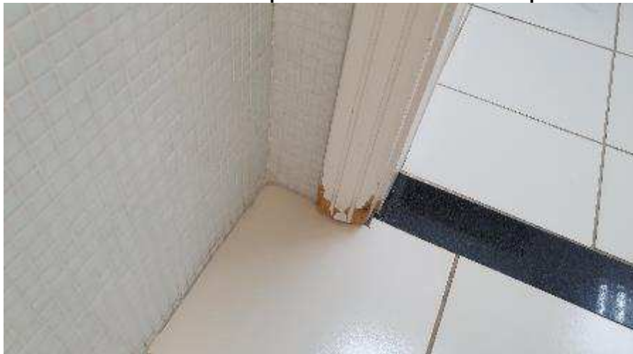
Imagem 154 – Portas com defeitos por umidade – Sanitários do pavimento Térreo
