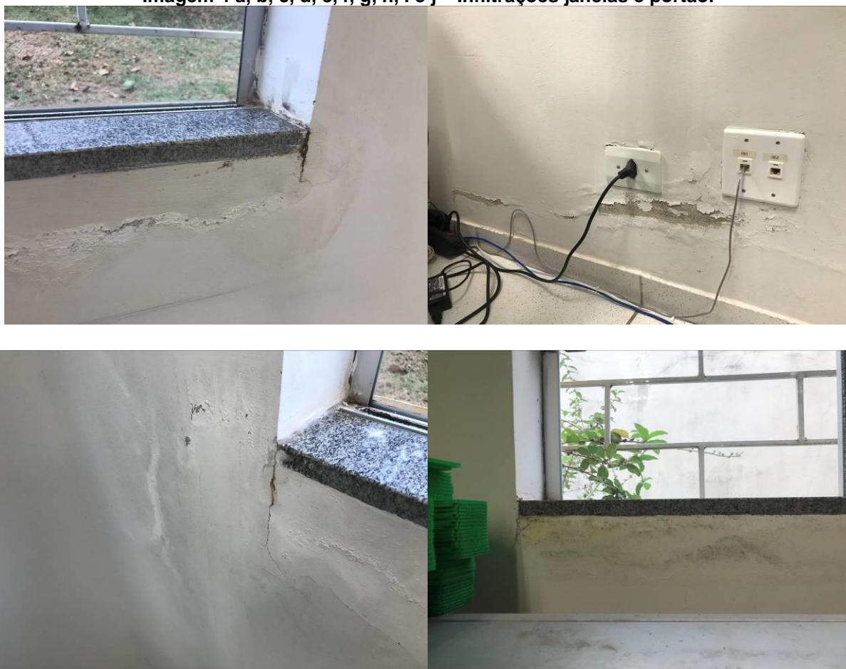
Imagem 4 a, b, c, d, e, f, g, h, i e j – Infiltrações janelas e portão.
