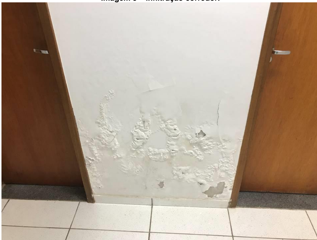
Imagem 5 – infiltração corredor.
