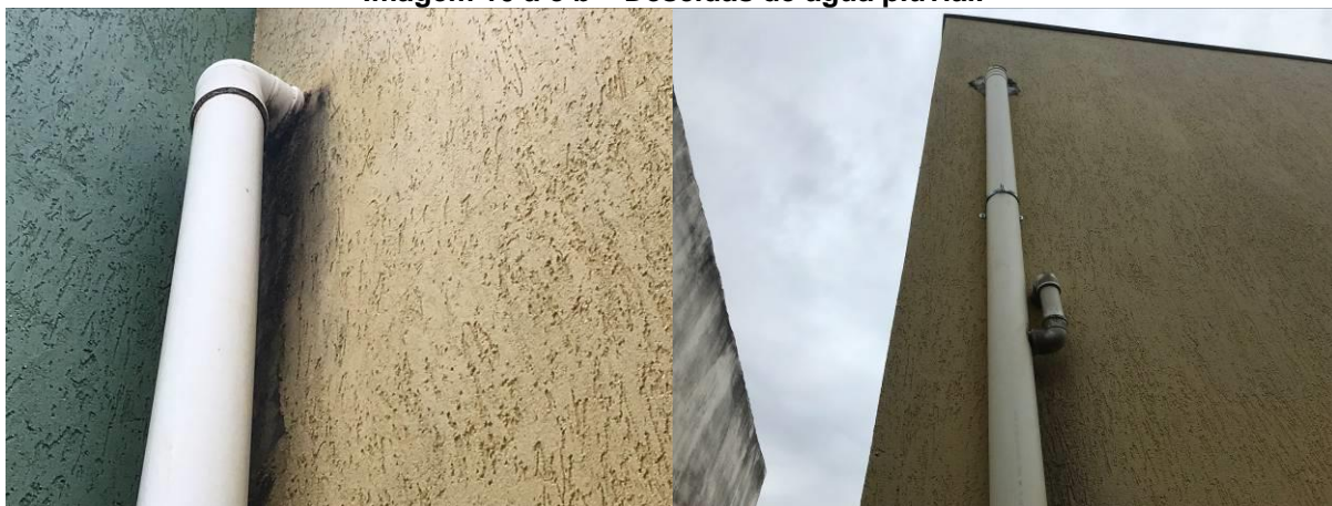
Imagem 10 a e b – Descidas de água pluvial.
