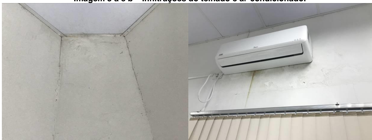
Imagem 3 a e b – Infiltrações do telhado e ar-condicionado.
