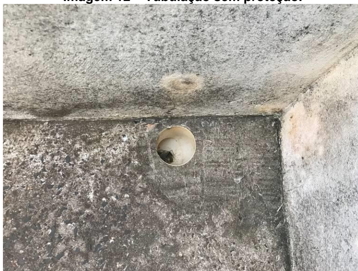
Imagem 12 – Tubulação sem proteção.
