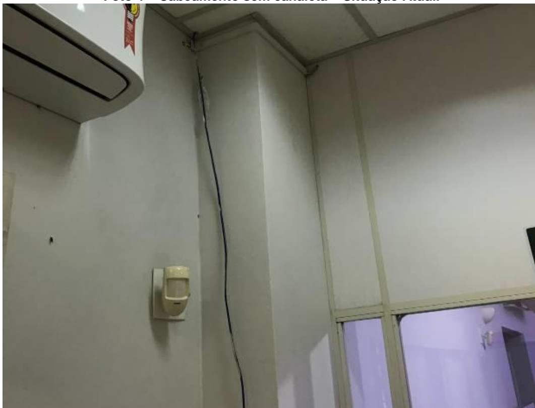
Foto 4 – Cabeamento sem canaleta – Situação Atual.
