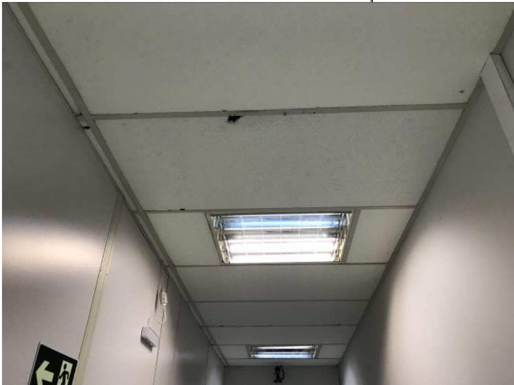
Foto 6 – Forro com Placa danificada – Situação Atual.
