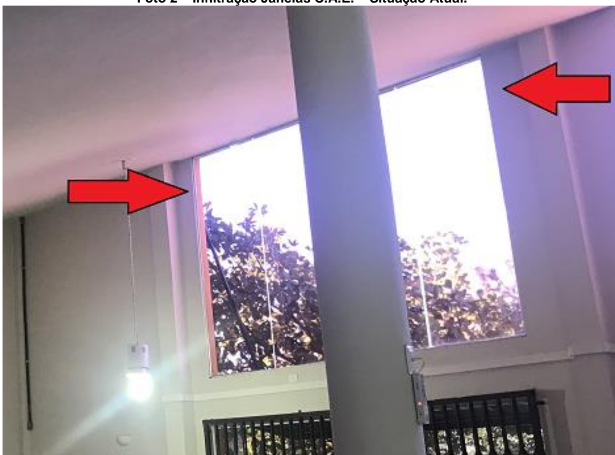
Foto 2 – Infiltração Janelas C.A.E. – Situação Atual.
