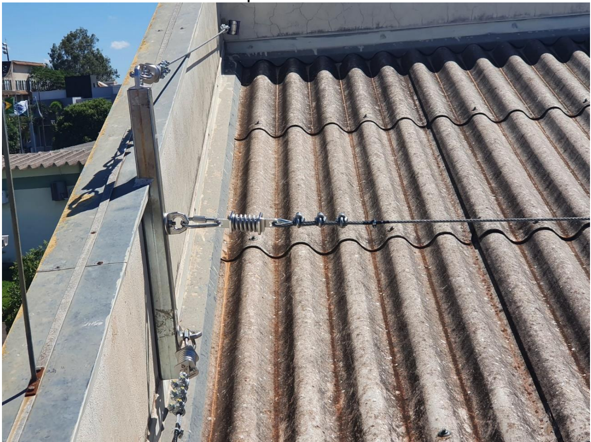
Suporte de ancoragem, com 3 pontos, instalação com fixação química na lateral de platibanda
