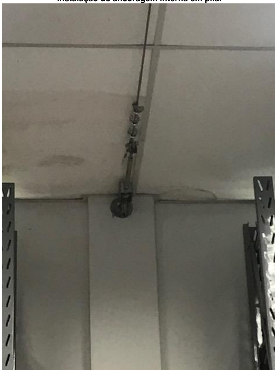
Instalação de ancoragem interna em pilar
