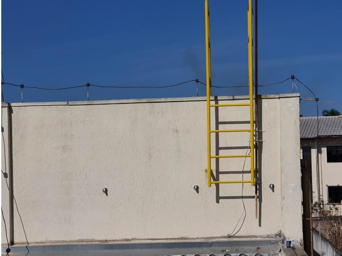
Escada marinheiro em cobertura, acesso entre telhados
