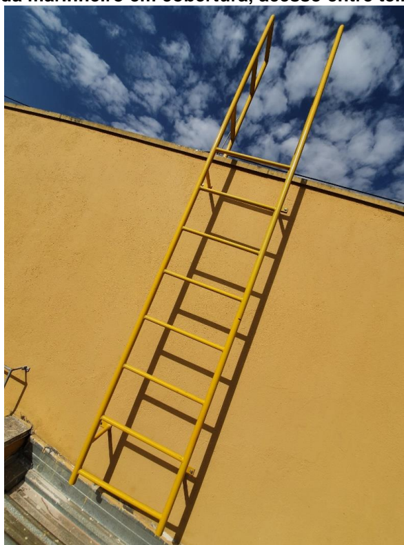
Escada marinheiro em cobertura, acesso entre telhados
