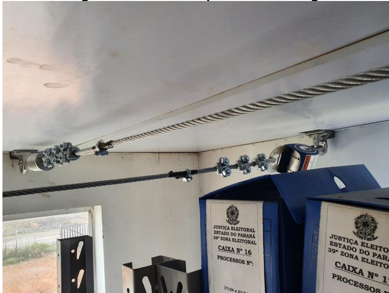
Suportes de ancoragem internos. Com ponto de ancoragem abaixo do forro
