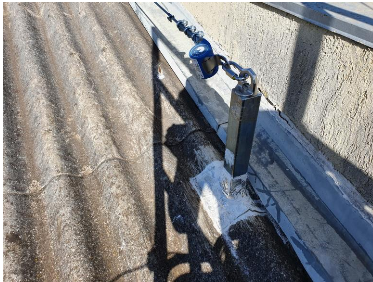
Suporte de ancoragem, com 1 ponto e vedação, instalação com fixação na estrutura do telhado.
